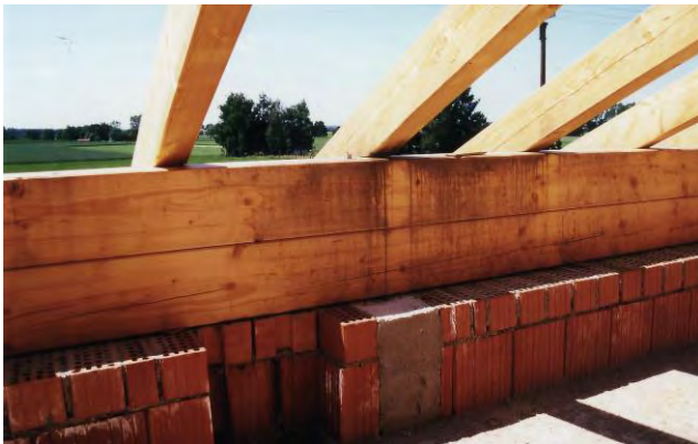
Bild 1: Verschmutzungen an der Fußpfette des Dachstuhls
