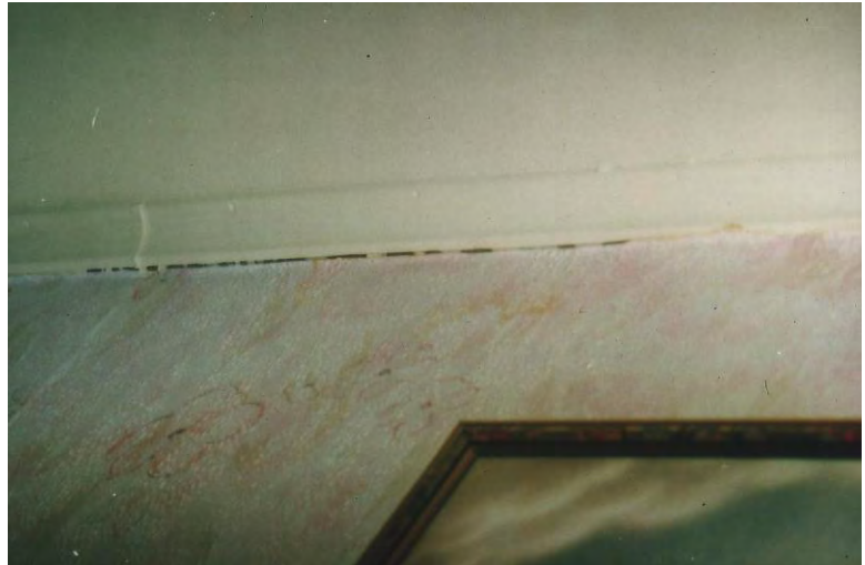
Bild 1: Fuge zwischen der Giebelwand und der Obergeschoßdecke
