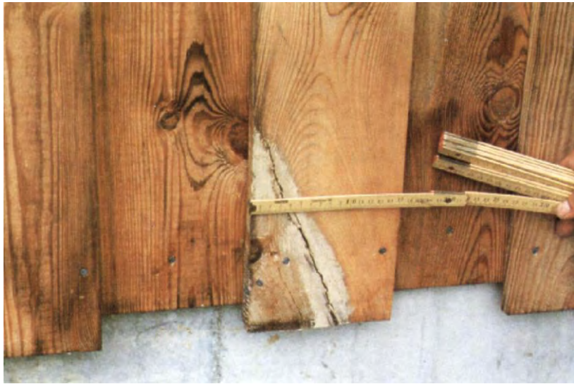
Bild 2.1-6a unzulässige Risse bei Außenwandbe- kleidungen [Foto: WEKA-1]
