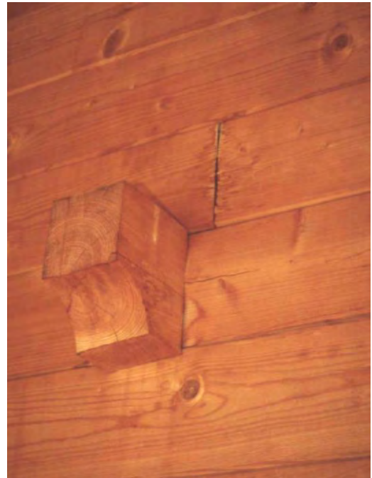
Bild 3: Tauwasserausfall an einem Längsstoß der Außenwand
