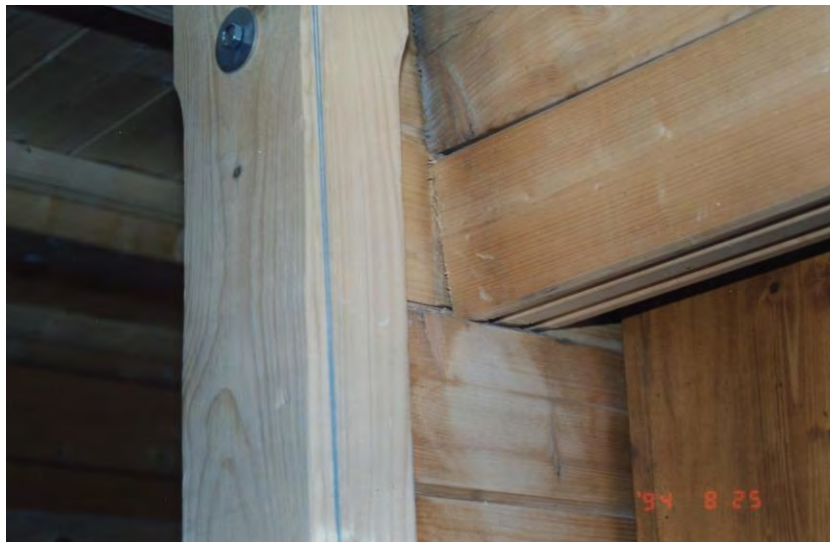
Bild 3.2-17 Fehlerhafte Ausführung: Unterzug mit einer Auflagertiefe von nur 15 mm [Foto: Macha]
