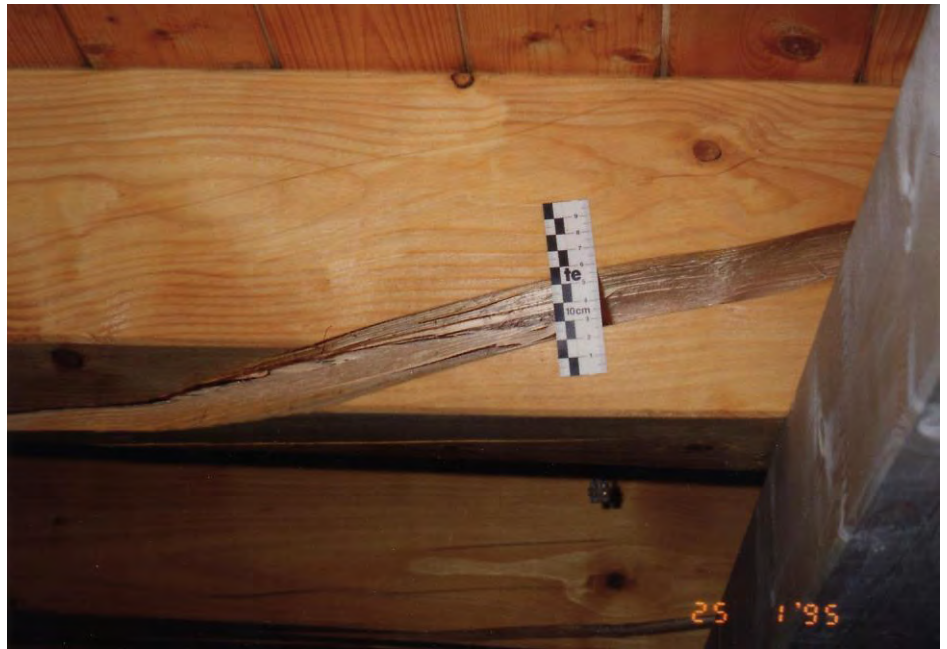
Bild 2.1-1 Bruch eines Deckenbalkens wegen Schrägfaserigkeit [Foto: Schmidt]
