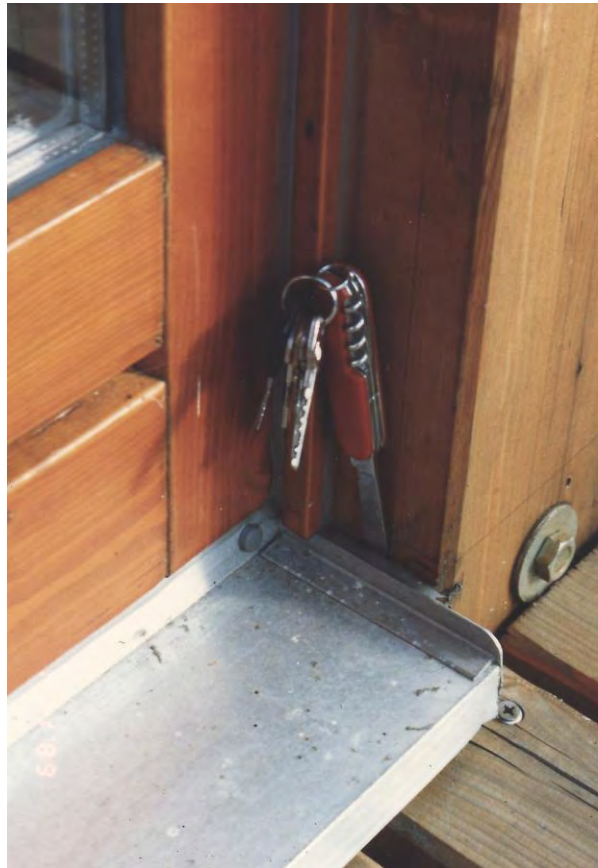
Bild 2: aufgerissene Silikonabdichtung zwischen der Alu-Sohlbank und der Holzstütze
