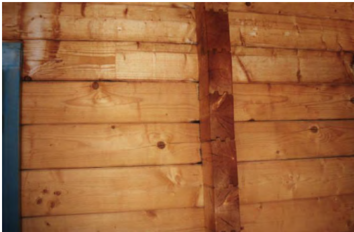
Bild 1: Tauwasseranfall an der Blockwandkonstruktion
