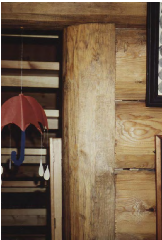
Bild 2: Halbrunde Stütze an der Treppenhauswand; klaffende Fugen zwischen den Blockhölzern
