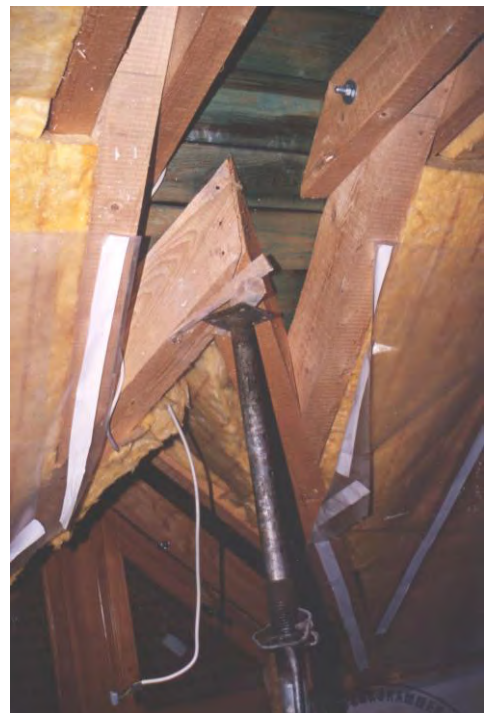
Bild 2: Provisorisch unterstützte Kehlsparren der Dachgaube
