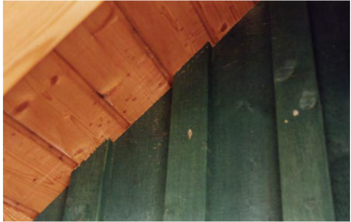
Bild 1: Tauwasserbildung an der Unterseite der Dachschalung
