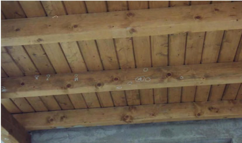
Bild 1: Untersicht der Balkenlage mit den markierten Ausfluglöchern
