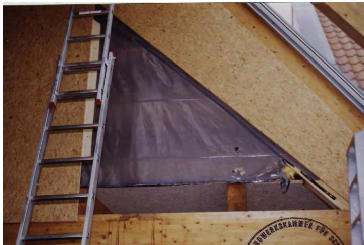
Bild 2: geöffnete Giebelwand braune Schlieren an dem unteren Tragbalken
