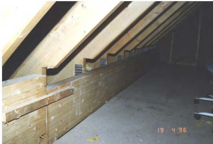
Bild 2: Ansicht der Dachkonstruktion des Blockhauses; die Sparren liegen nicht auf der Brettschichtholzpette auf
