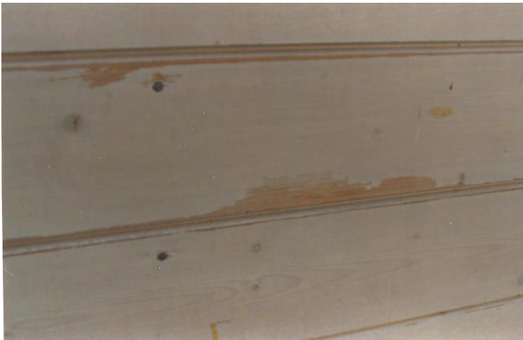
Bilder 2 & 3: Detailansichten der Farbabblösungen an den Kanten der Profilbrettschalung
