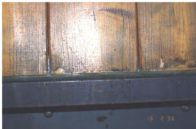
Bild 2: Abschluß der Blechverwahrung mit dauerelastischem Fugenmaterial; Fugen zwischen den Bohlen
