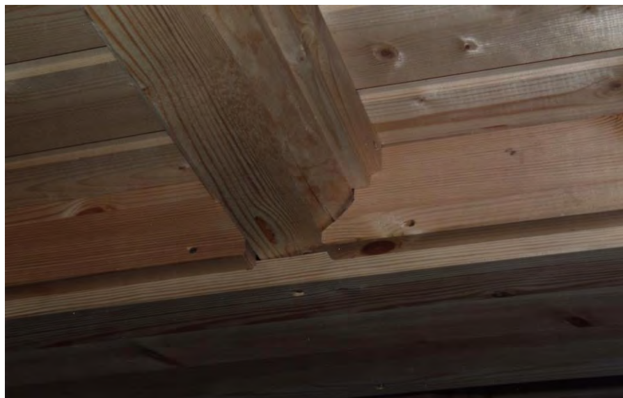
Bild 2.1-3 unzulässige Baumkante bei Schnittklasse S [Foto: Frech]
