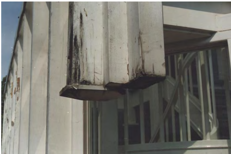
Bild 3: Detail des zerstörten unteren Bereichs des Hängepfostens
