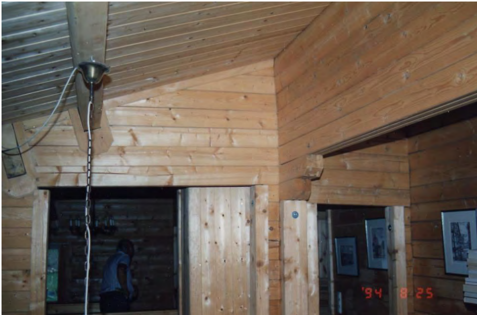
Bild 1: Kreuzungspunkt Mittelwand – Firstwand (Firstpfette) Rechts im Bild: die sechs übereinander angeordneten Blockbalken Links im Bild: Auflagerung der Zwischenpfette auf dem Unterzug, der sich unter der Last durchbiegt
