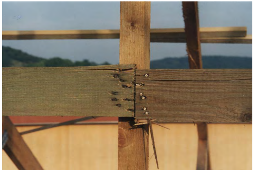
Bild 3.2-38 Nicht eingehaltene Mindestabstände [Foto: Steinmetz]
