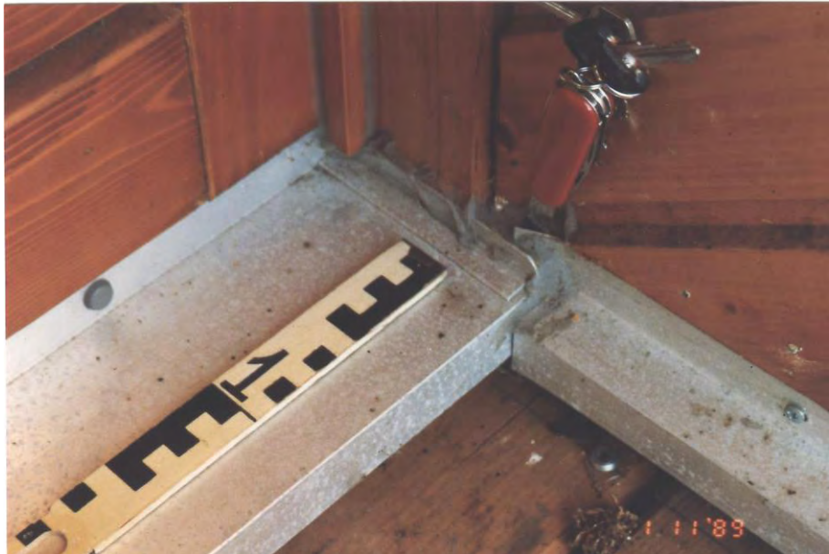
Bild 1: offene Fuge zwischen der Sohlbank und einem Brüstungselement
