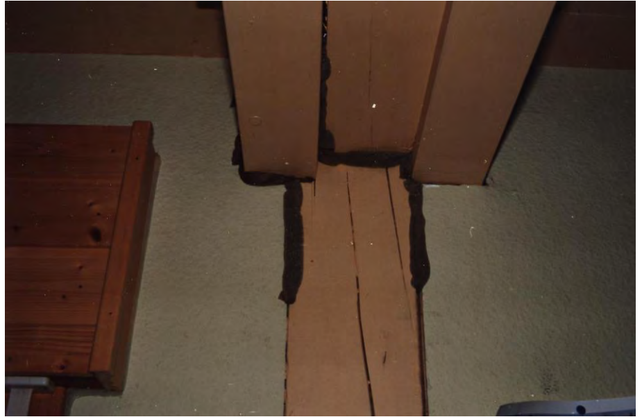
Bild 2.1-19b Fugen notdürftig ausgestopft [Foto: Frech]
