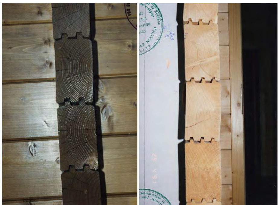
Bild 3.2-15 Fehlerhafte Ausführung: Fuge- öffnungen und Verformungen bei Blockbohlenwand; Block- bohlen nicht wechselseitig verlegt [Foto: Galiläa, Macha]
