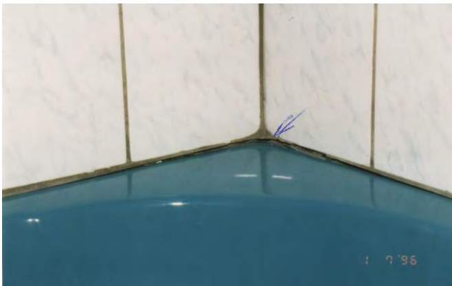
Bild 3: Abgerissene Verfugung im Anschluß der Badewanne an den Fliesenspiegel
