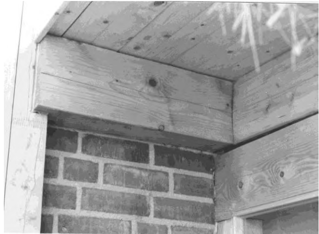
Bild 1: Auflager des westlichen Streichbalkens : Klaffende Fuge zwischen Streichbalken und Rähm
