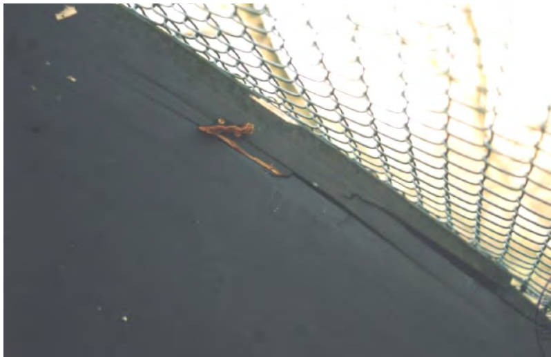
Bild 1: Fruchtkörper des Blättlings im Bereich der 2. und 3. Lamelle von oben, aufgegangene Keilzinkenverbindung in der obersten Lamelle
