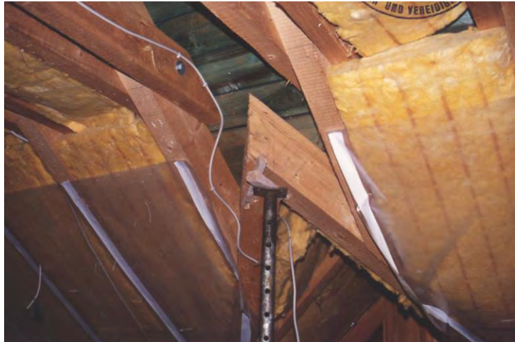
Bild 1: Innenansicht der Gaubenkonstruktion
