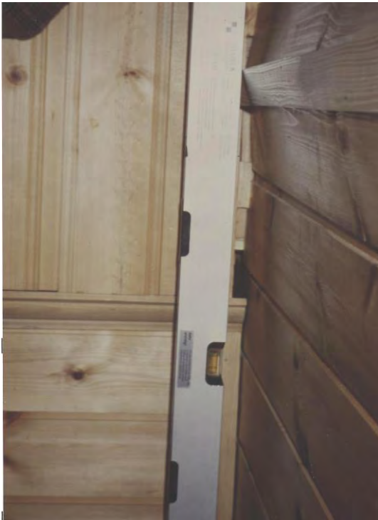
Bild 3: Ausgebeulte Bekleidung der Treppenhaus Leichtwand
