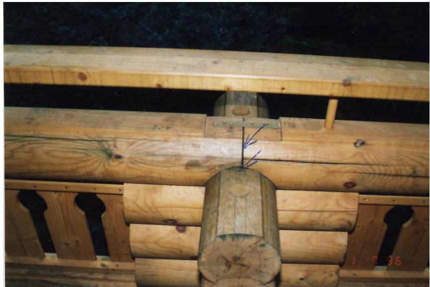
Bild 6.3-42 Absehbarer Schaden: offene Stoßfuge [Foto: Macha]
