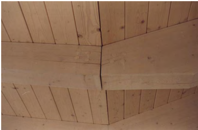
Bild 1: Detail eines Sparrenanschlusses Ein Riß verläuft direkt unterhalb der eingelassenen Verbindungsmitteln; kleinere Risse sind zusätzlich im Bereich der Verbindungsmittel/Stabdübel vorhanden.
