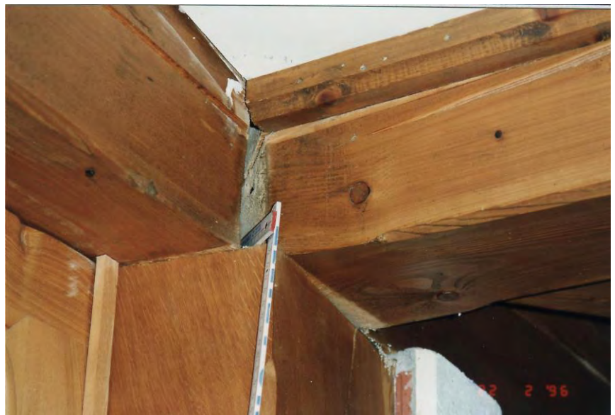
Bild 2.1-37 Anschluß Deckenbalken: Fugen, Verdrehungen und Rißbildung durch Schwinden [Foto: Schmidt]
