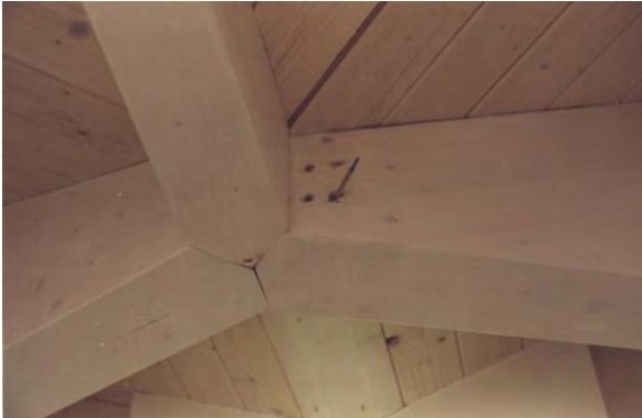
Bild 3: Ansicht eines Knotenpunktes; offene Bohr- löcher und fehlende Stabdübel
