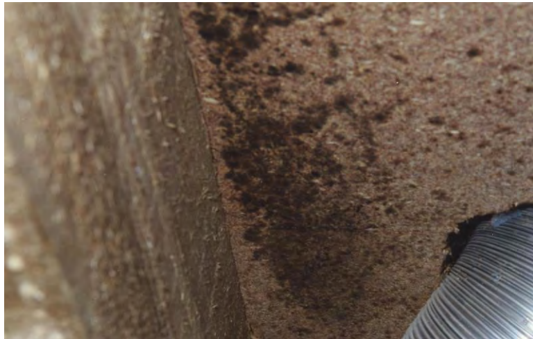
Bild 2: Dichter Pilzrasen neben einem Sparren
