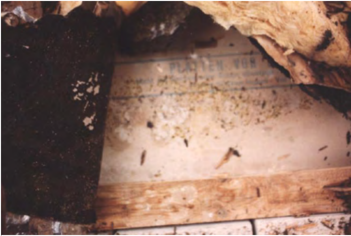
Bild 2: Schimmelpilz an der Oberseite der Gipskartonplatte
