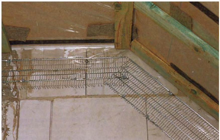
Bild 5.4-53 Anschluß an Massivwand mit Putzträger [Foto: Pohl]
