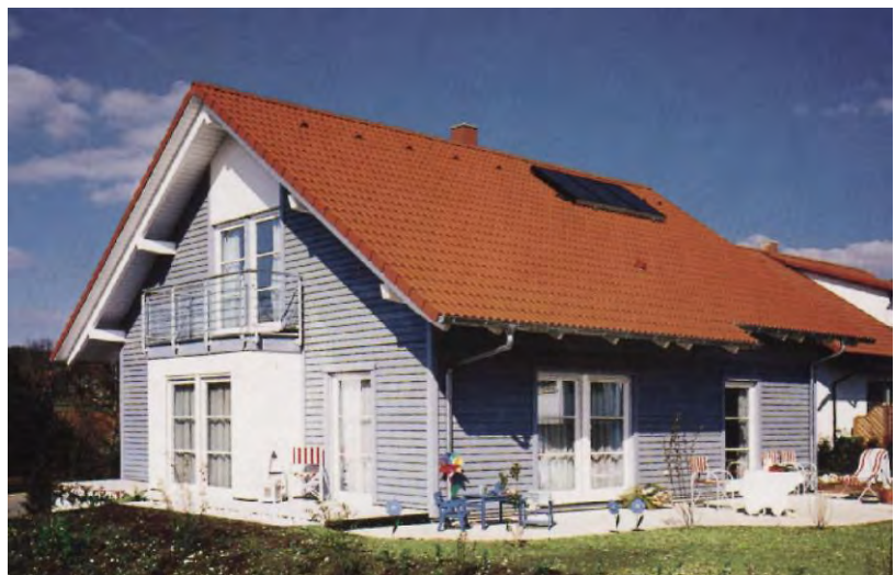
Bild 1.4-1 Wohnhaus in Holzrahmen-/ Holztafelbauweise [IFO – Das Holzhaus]
