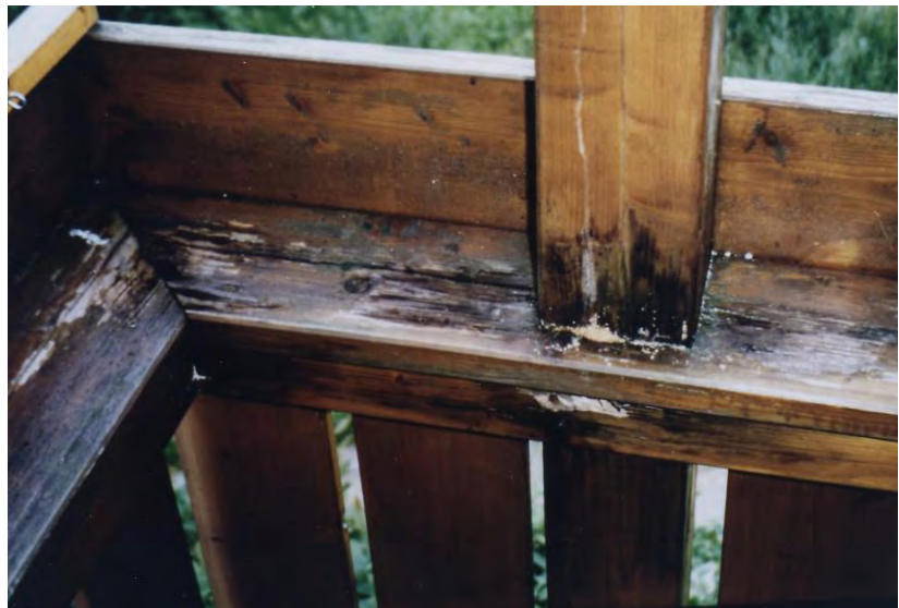
Bild 6.3-43 Fäulnis durch stehendes Wasser und Kapillarleitung bei Gehrung der Geländerbretter und Durch- dringung der Stütze [Foto: Trübswetter]
