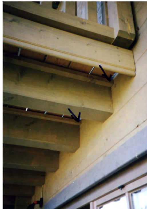
Bild 2: Balkon-Unterseite auf der Nordwestseite. Wasser dringt entlang der Stichbalken ins Innere.
