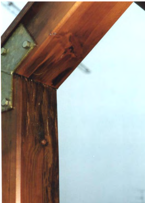
Bild 2 oben: Fäulnis in der Holkehle, Insektenlöcher teils verkittet
