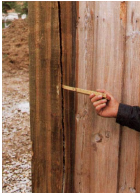
Bild 2.1-6b unzulässige Risse bei Außenwandbe- kleidungen [Foto: WEKA-1]
