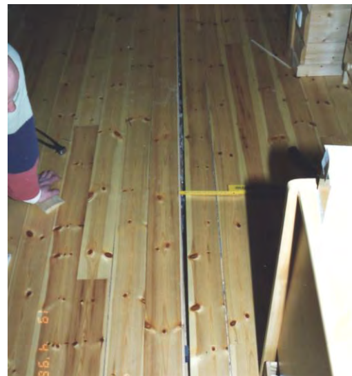
Bild 3: deutlich sichtbarer Spalt in der Fußbodendielung im Bereich über dem Unterzug der Decke über dem EG
