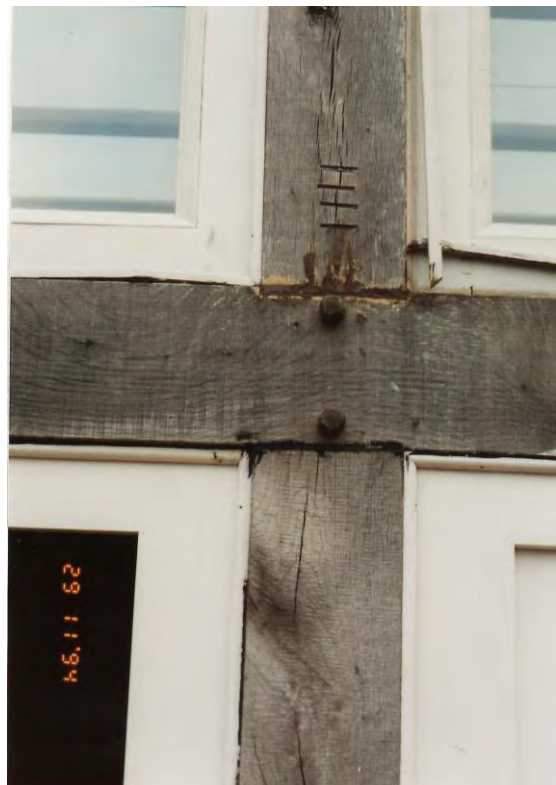
Bild 1: Detail der Verbindungsstelle zwischen Stütze und Riegel
