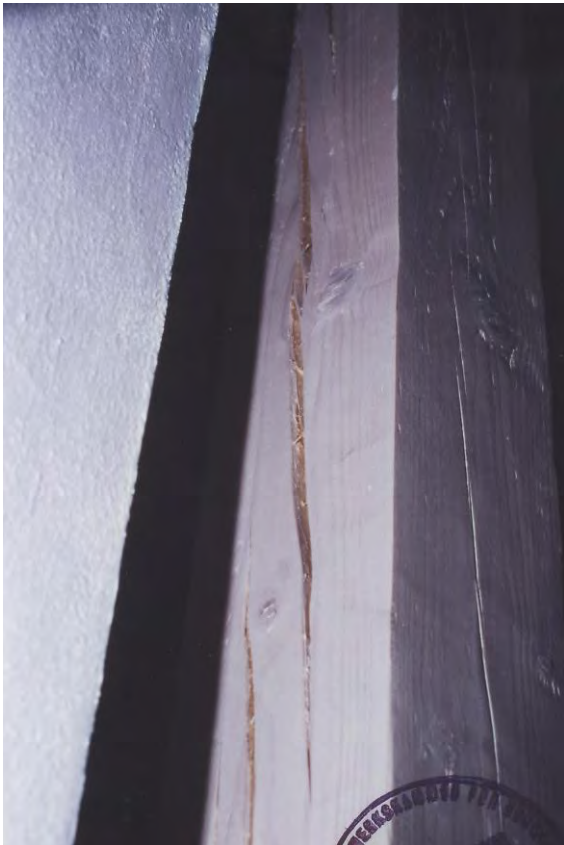
Bild 1: Trocknungsrisse in Stütze ① im Erdgeschoß
