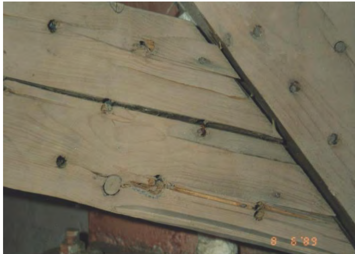
Bild 3: Ansicht der Diagonalstäbe die keinen Kontakt zu den Gurtstäben haben / deutliche Risse im Holz
