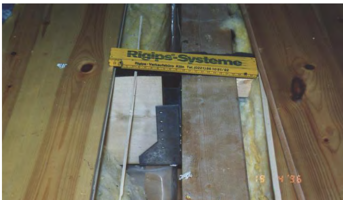
Bild 5: Ansicht des Auflagers der Deckenbalkens; infolge der fehlenden Vernagelung ist keine kraftschlüssige Verbindung der Balken mit dem Unterzug vorhanden
