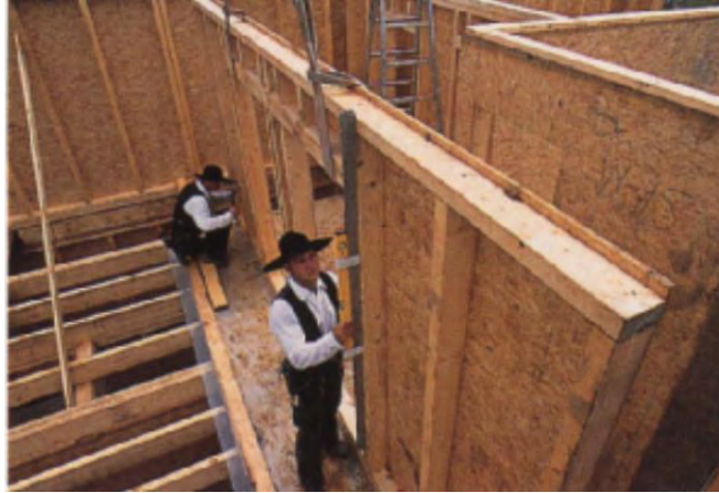
Bild 1.4-2 Aufrichten teilweise vorgefertigter Wandelemente im Holzrahmenbau [IFO - Das Holzhaus]
