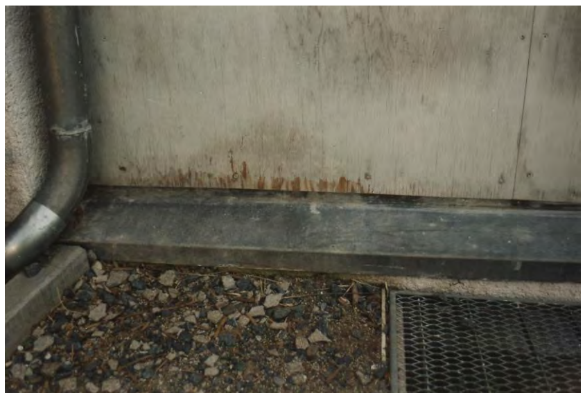
Bild 6.3-18 Verwitterte BFU-Fassadenplatten durch Spritzwasser [Foto: VHT]
