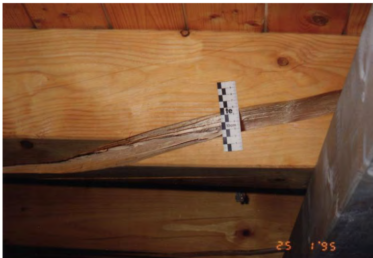
Bild 1: Riß im 4. Deckenbalken direkt an der Unterstützung mit dem Joch
