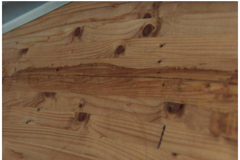
Bild 1: bereits nachgebesserte Risse in BSH-Träger
