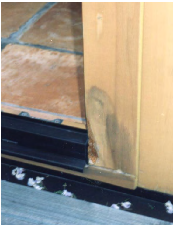
Bild 1: Fäulnis an einem Türstock; Wasserspuren sind deutlich erkennbar
