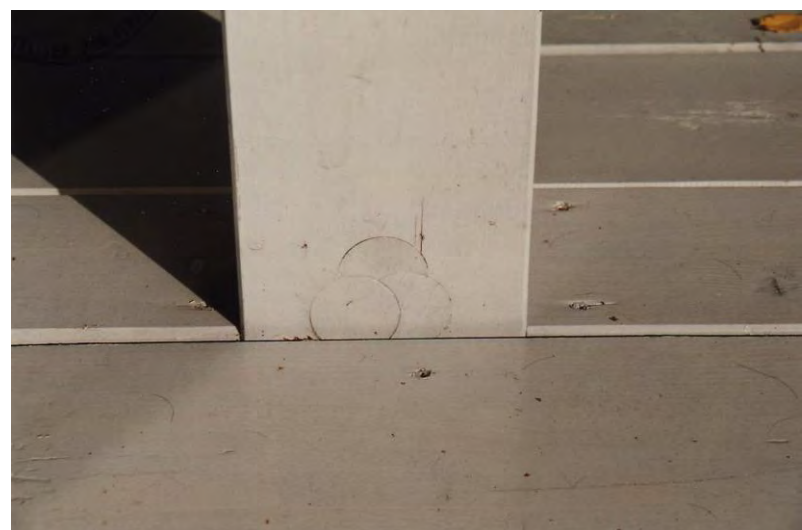
Bild 3.2-45 Ansammlung von „Flickdübeln“ bei Pfostenanschluß [Foto: Galiläa]
