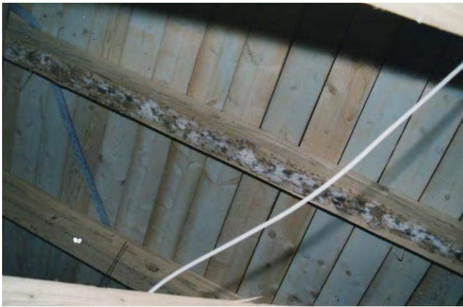
Bild 1 & 2: Mit Schimmelpilz befallene Sparren
