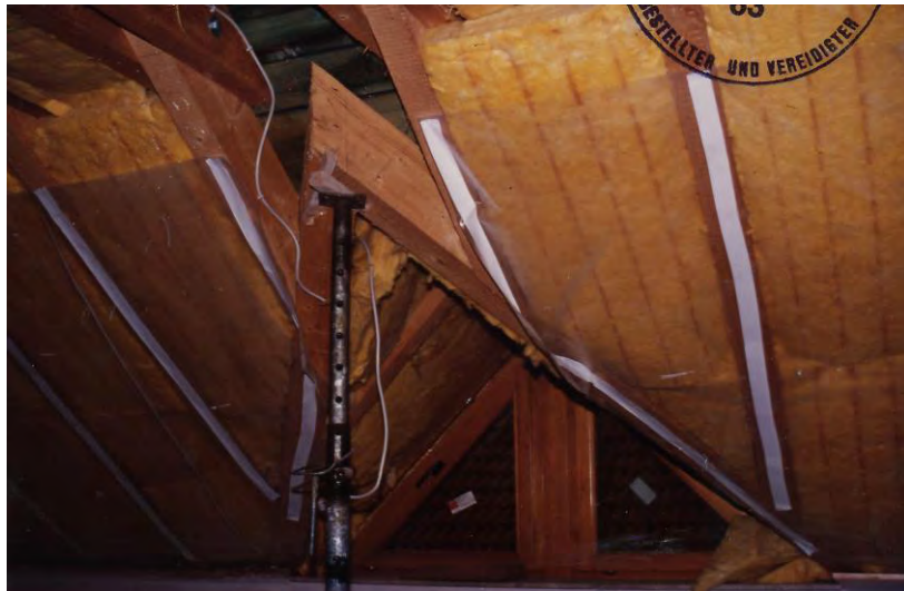
Bild 3.6-2 Dachgaube ohne Firstpfette und Auflager [Foto: Galiläa]
