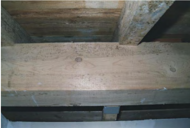
Bild 3: Mit Schimmelpilzen befallene Mittelpfette
