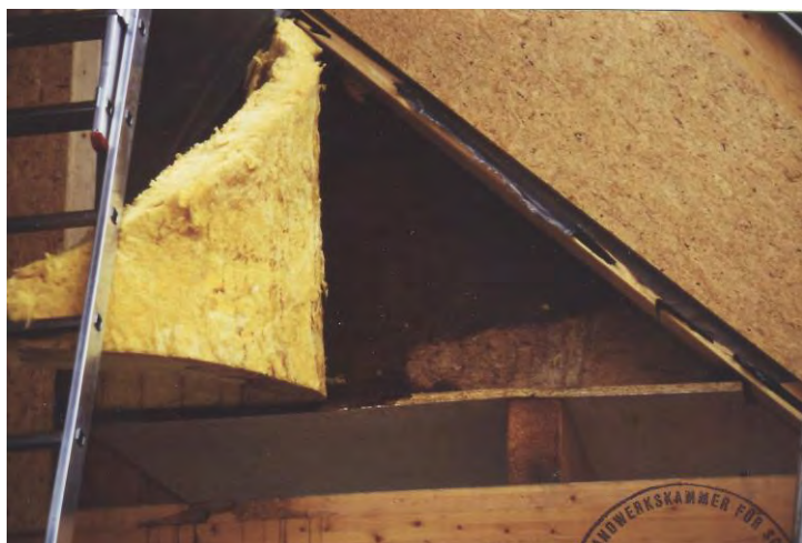
Bild 3: durchfeuchtete Wärmedämmung und Schlieren an der hinteren OSB-Platte
