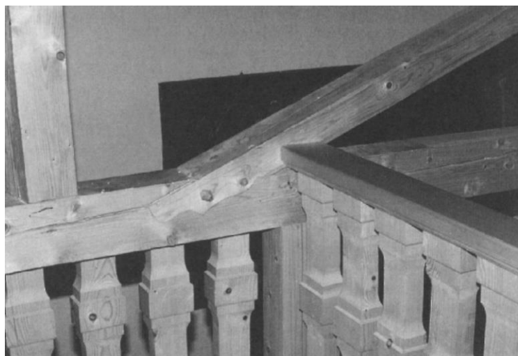
Bild 2: Anschluß der Hängewerkstrebe an den Untergurt mit seitlichem Zierblatt
