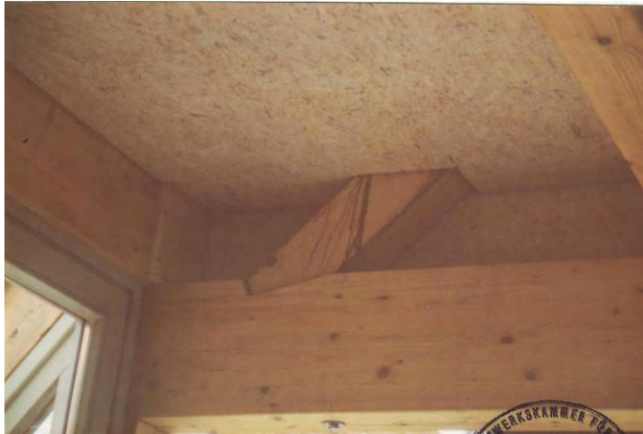
Bild 1: Braune Schlieren an einem Sparren der Giebelkonstruktion
