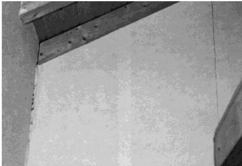
Bild 1: Risse an dem Beplankungsstoß und der Raumecke
