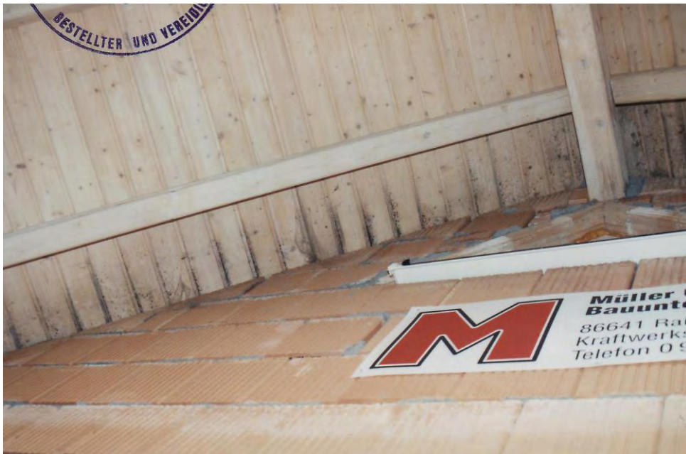
Bild 3: Feuchtflecken an der Unterseite der Dachschalung
