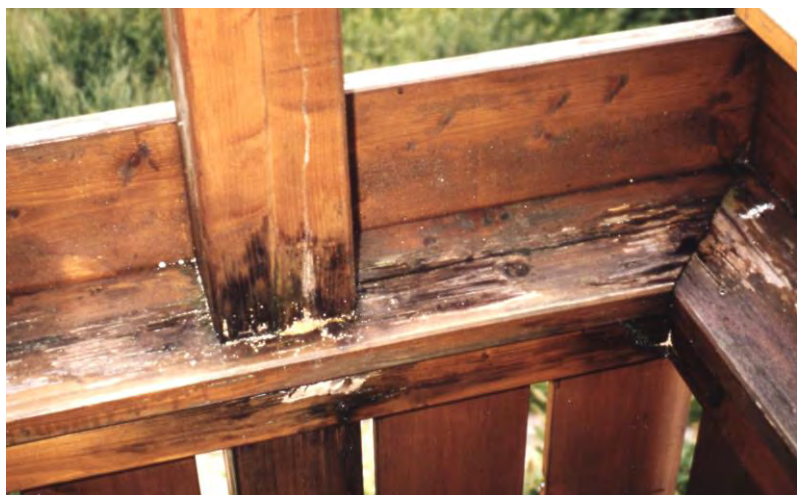
Bild 2: starke Fäulnis an der Hängestütze sowie am Brüstungselement
