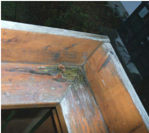
Bild 3: Pilzbefall an der durchfeuchteten Ecke des Brüstungselementes
