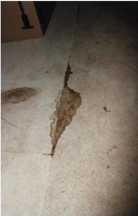
Bild 1: Feuchtefleck an der Stoßstelle der Sperrholzplatten
