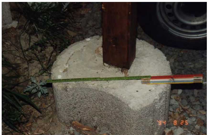
Bild 3.2-39 Nicht fachgerechter Stützenanschluß [Foto: Macha]
