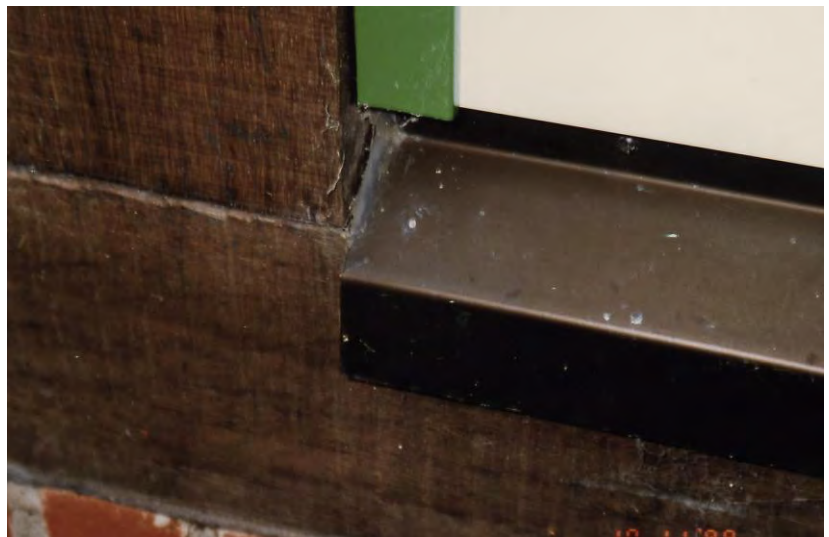
Bild 6.3-27 Fenster-Sohlbank ohne seitliche Aufkantung [Foto: Schmidt]
