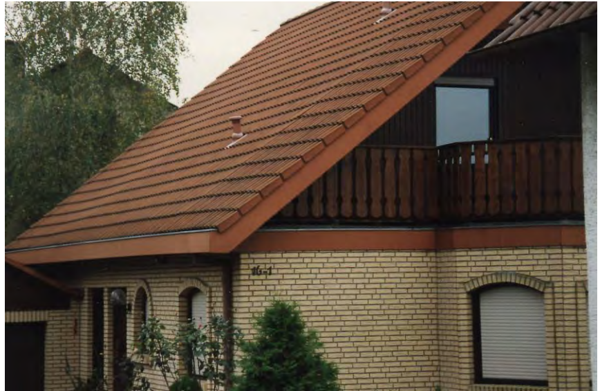
Bild 1: Knick in der Dachfläche
