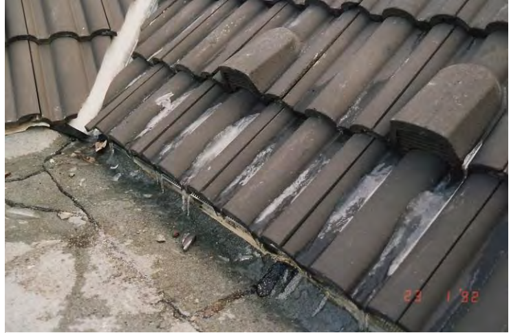
Bild 1: Eisschanzenbildung auf den Betondachsteinen
