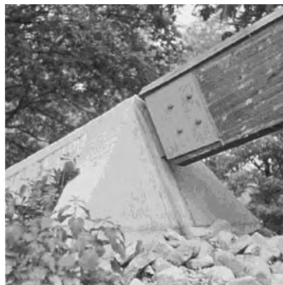
Bild 6.3-6 Abdeckungen von Holzbauteilen [IFO – Baulicher Holzschutz]
