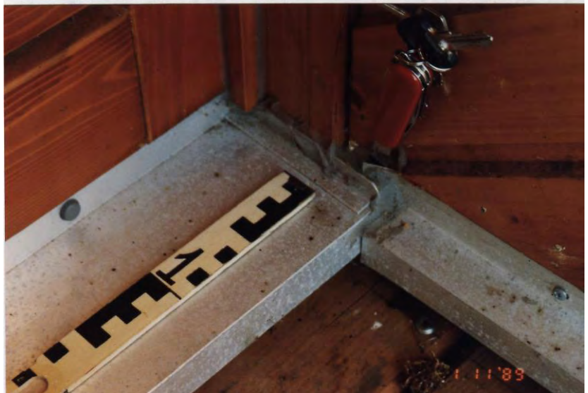
Bild 6.3-26 undichte Fenster-Sohlbank im Eckbereich [Foto: Schmidt]
