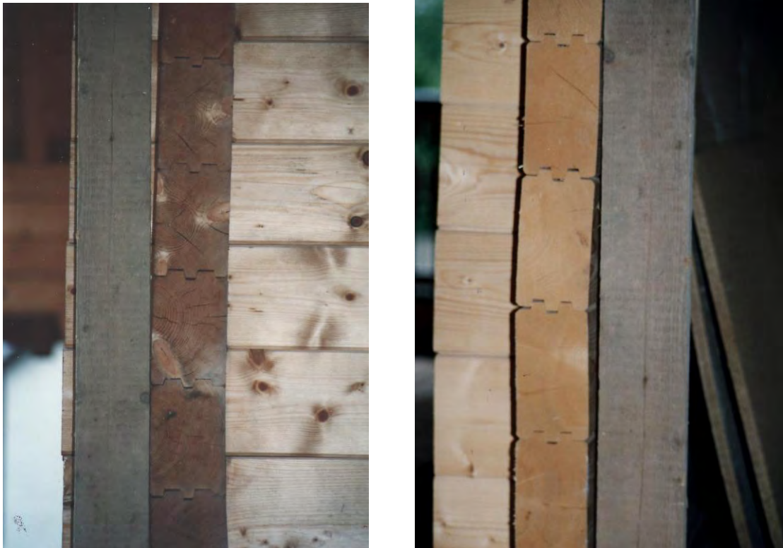
Bild 2 & 3: Verkrümmung der Innenwände infolge der nicht wechselseitigen Anordnung der Bohlen
