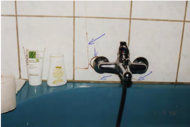
Bild 2: Nicht fachgerechte Abdichtung der Badewannenarmatur; Wasser kann ungehindert in die Wandkonstruktion eindringen
