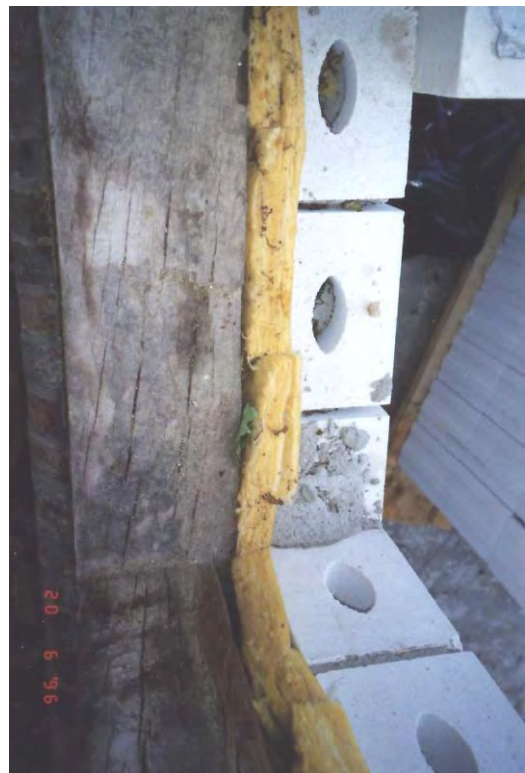
Bild 2: vermodertes Holz in der Leibung; keine ausreichende Luftschicht
