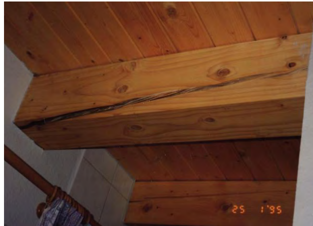
Bild 3 oben : Riß im 5. Deckenbalken beim Mittelaufleger
