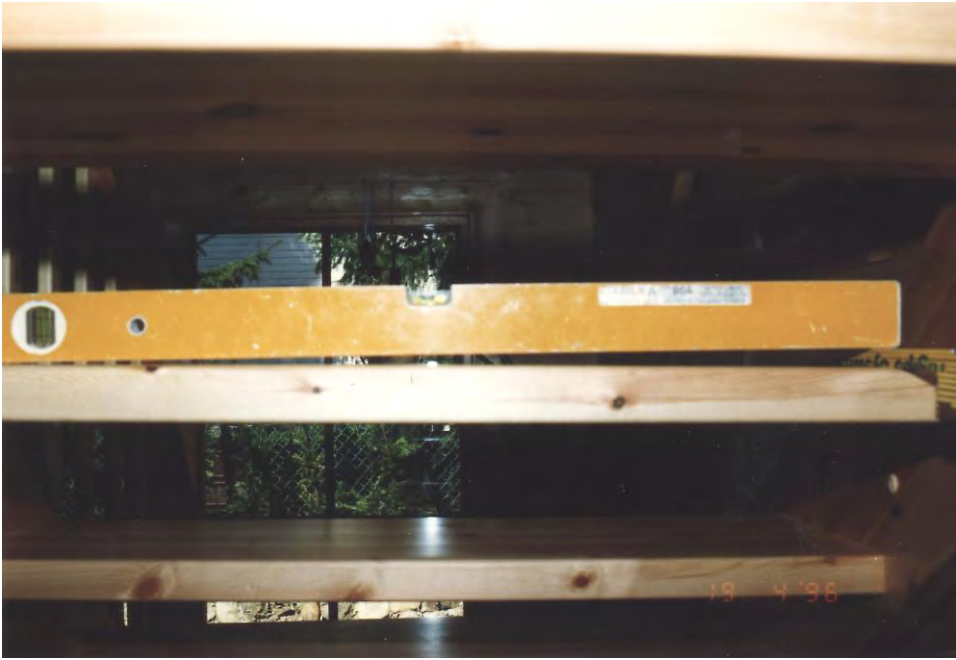
Bild 3: Schiefstellung der Treppenstufen infolge der Setzungen der Blockhauswand
