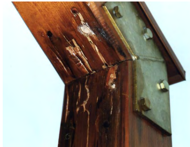
Bild 2 oben: Fäulnis in der Holkehle, Insektenlöcher teils verkittet
