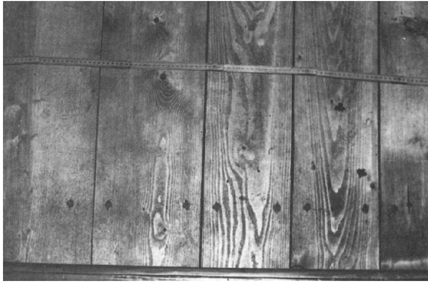
Bild 1: Dielenfußboden mit zu großen Fugen
