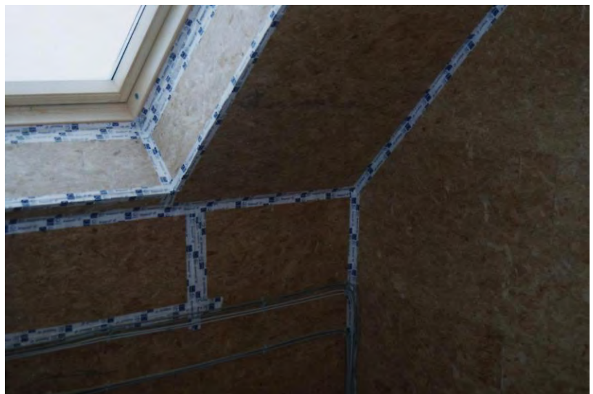
Bild 5.4-46 Luftdicht ausgeführte Stöße von HWSt-Platten mittels Klebebändern
