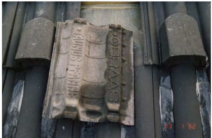
Bild 2: Detail der Eisschanzenbildung; die Unterseite des umgedrehten Dachsteins ist befeuchtet
