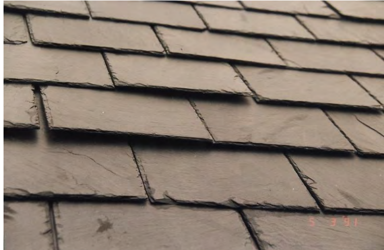
Bild 1: aufgewölbte Schieferdeckung des Dachs
