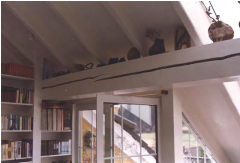
Bild 1 & 2: Ansicht des 25 mm breit aufklaffenden Trockenriß in der Mittelpfette.
