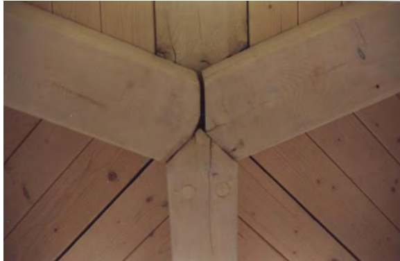
Bild 4: Ansicht eines Knotens von unten; große Fuge zwischen den Sparren
