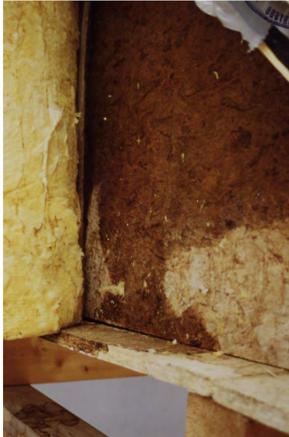
Bild 4: großer Feuchteffleck auf der rückseitigen OSB-Platte
