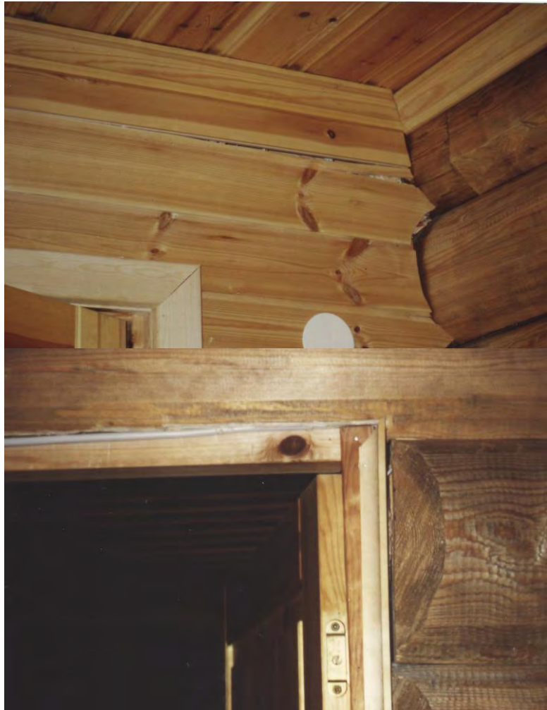
Bild 5: Zimmertür; Sturzbalken lagert auf Futter und Bekleidung auf
