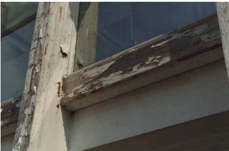
Bild 2: Anstrichschäden im linken oberen Eckbereich des Anbaus
