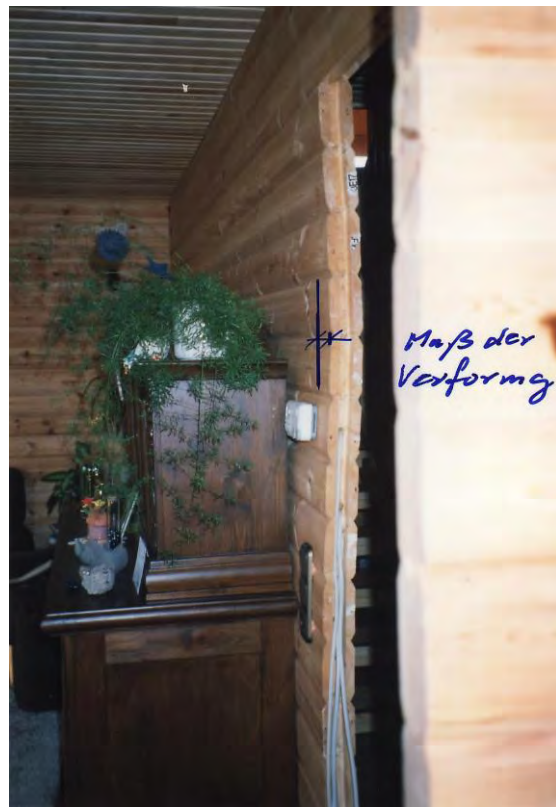
Bild 2: Verformung der Treppenhauswand im Erdgeschoß
