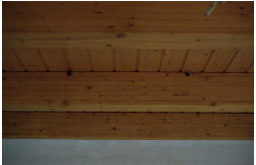
Bild 2.1-4 unzulässige Ausfalläste bei Sonderklasse [Foto: Frech]
