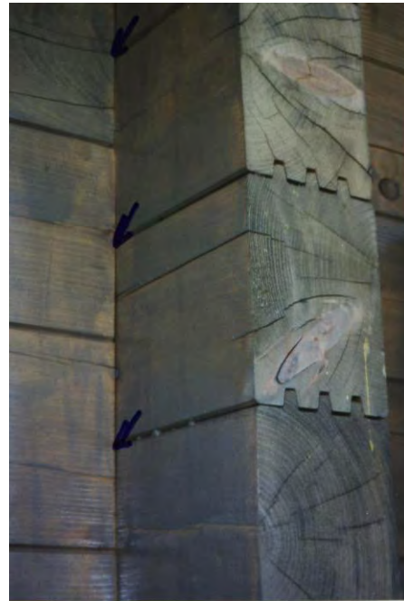
Bild 4: Innenwand durchdringt die Außenwand; Entlang der Fugen der Blöcke dringt Regenwasser ins Innere
