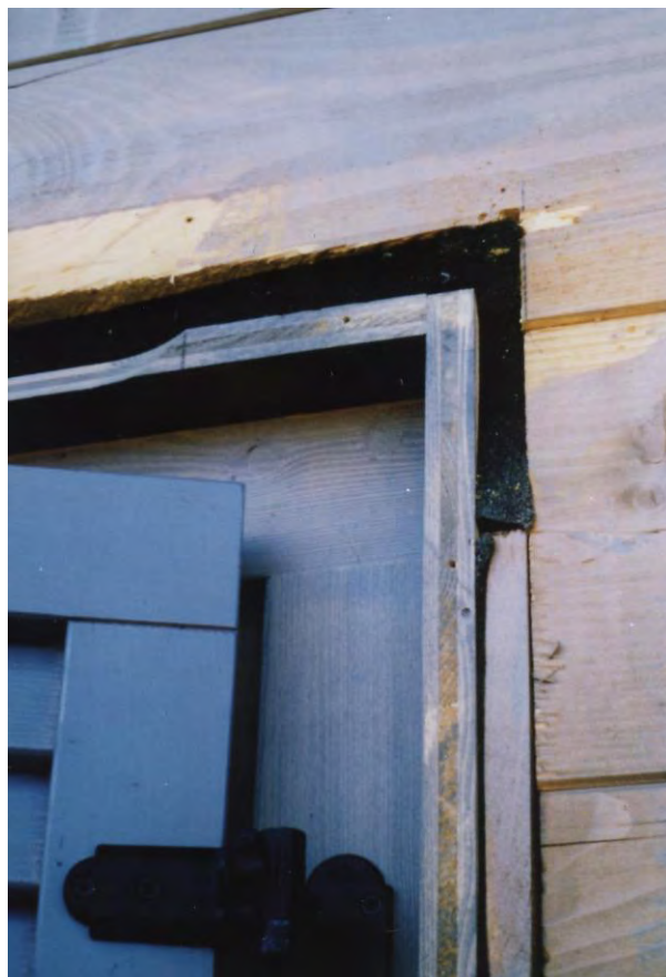
Bild 3.3-6 Unwirksame Abdichtung durch unzureichende Komprimierung [Foto: Trübswetter]
