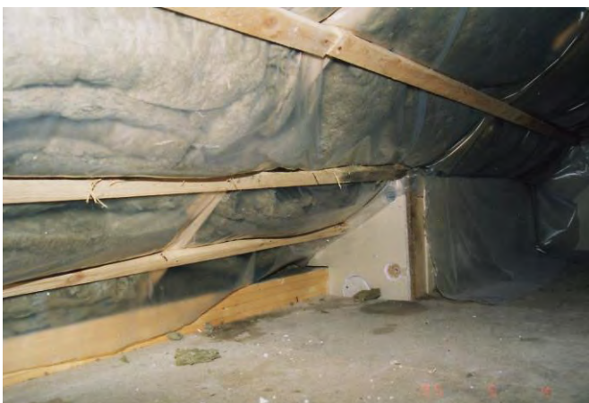
Bild 2: Undichter Anschluß der Folie und der Dämmung des Daches im Schwellenbereich
