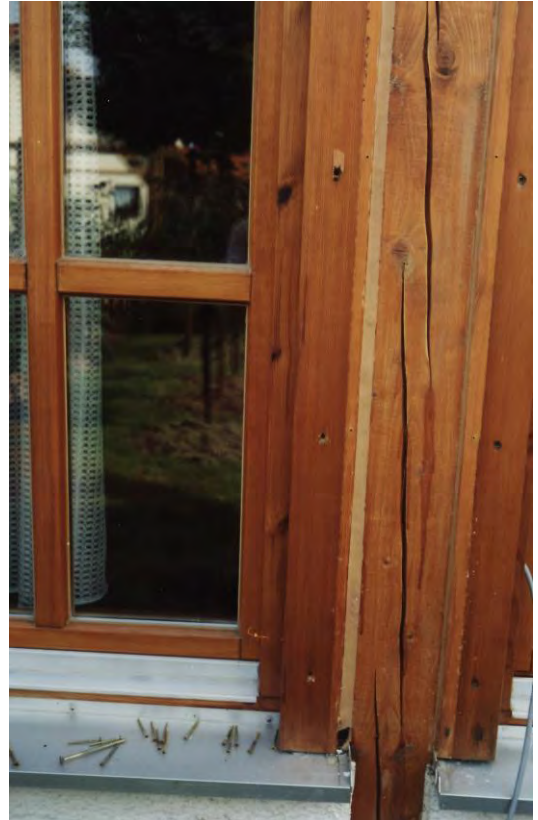
Bild 3.4-3 Nicht objektbezogene Holzauswahl: rissige Stütze zwischen zwei Fenstern, nicht fachgerechte Abdichtung [Foto: Frech]
