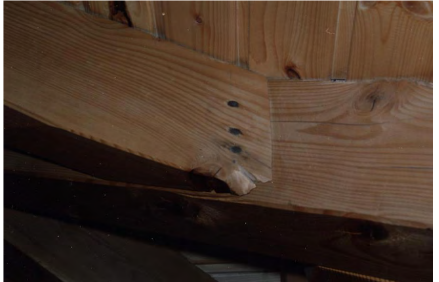
Bild 3.2-37 Nicht fachgerechter Nagelanschluß [Foto: Frech]
