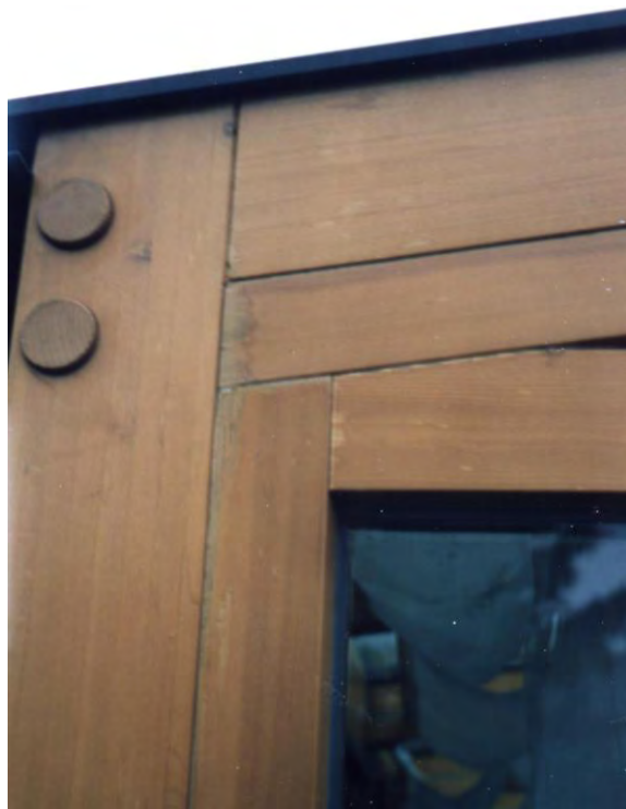
Bild 2: Spuren eingedrungenen Wassers an der Stirnkante des unteren Frieses
