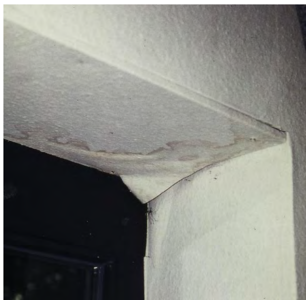
Bild 5.4-4 Ablösung der Tapete durch Wassereintritt bei Fenster [Foto: VHT]
