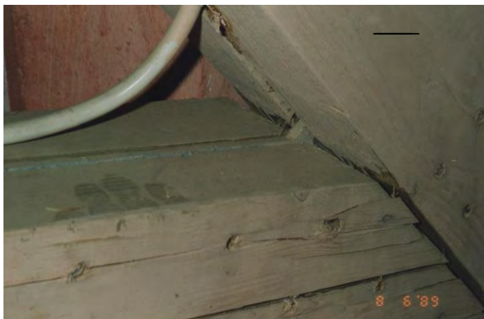
Bild 2: Ansicht des herausragenden Stahlblechs und der Risse im Knotenpunkt
