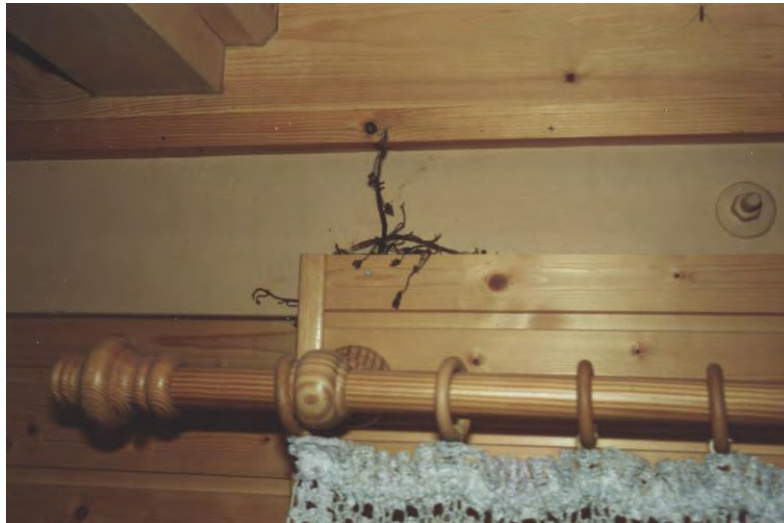
Bild 3: Durch eine Fuge von Außen durchgewachsener Efeu
