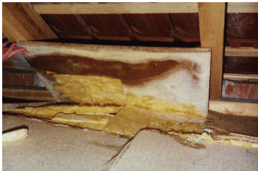
Bild 2: Eisbildung an der Unterseite der aufgewölbten Platten
