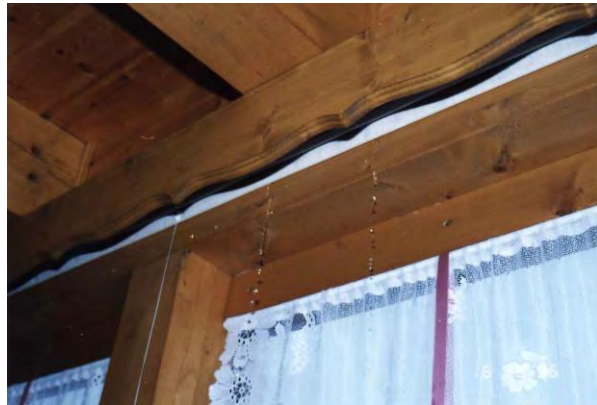
Bild 4: Ansicht des Fenstersturzes und des eintretenden Wassers
