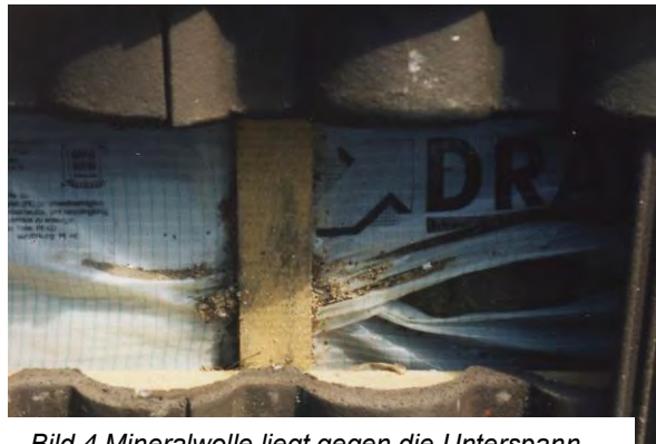
Bild 4 Mineralwolle liegt gegen die Unterspannbahn an
