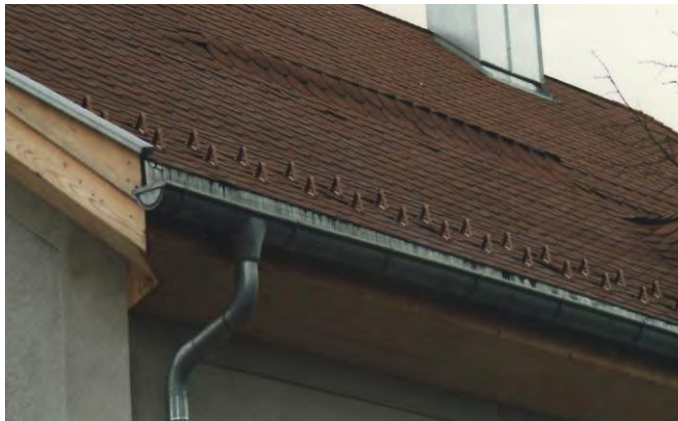
Bild 1: Verwerfung/Wölbung der Dachhaut
