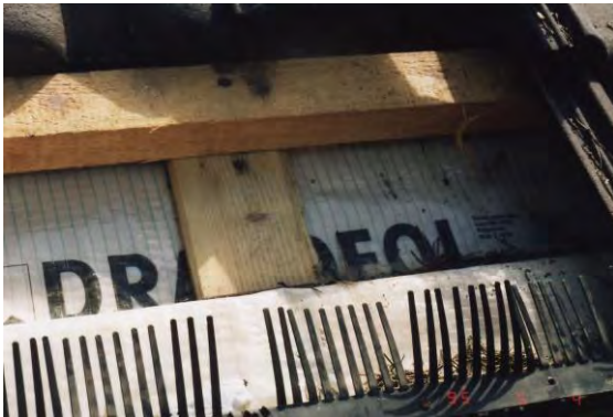
Bild 3 Wassersack im unteren Bereich der Unterspannbahn vor der Rinne
