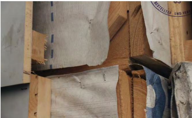
Bild 2: Detail der mangelhaft ausgeführten Winddichtung
