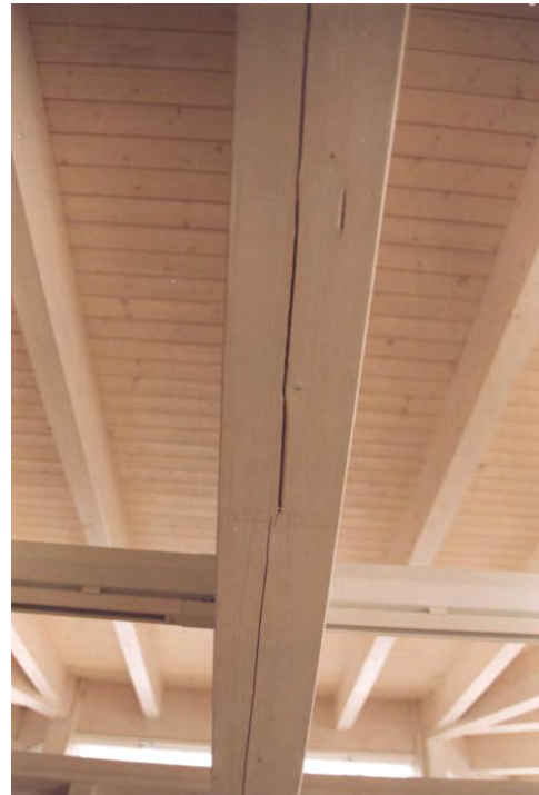
Bild 2: Riß an der Unterseite eines Brettschichtholzbinders.
