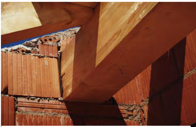
Bild 2: Mittelpfette liegt ohne Sperrschicht auf dem Mauerwerk auf
