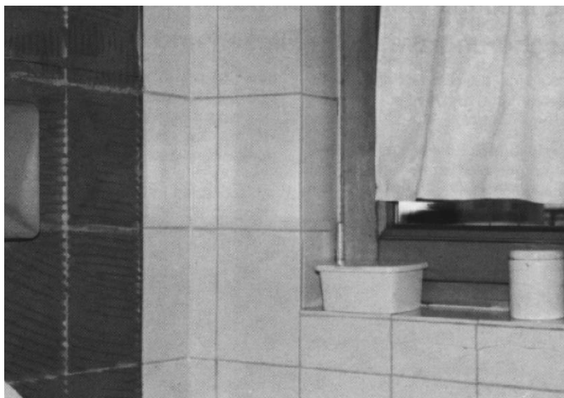
Bild 2: Risse sowie abgelöste Fliesen im Badezimmer
