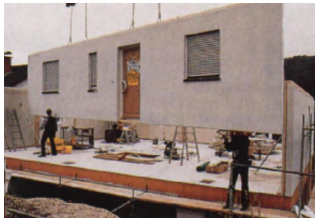
Bild 1.4-3 Montage eines Wandelementes im Holztafelbau [IFO - Das Holzhaus]
