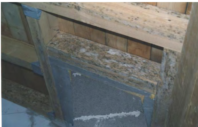
Bild 1 & 2: Mit Schimmelpilz befallene Sparren
