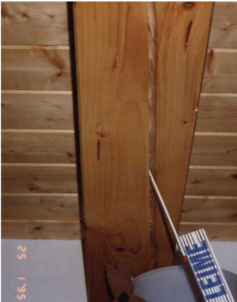
Bild 3 oben : Riß im 5. Deckenbalken beim Mittelaufleger
