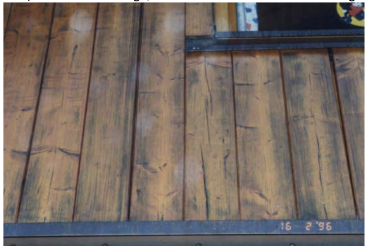
Bild 1: Fugen zwischen den Blockbalken
