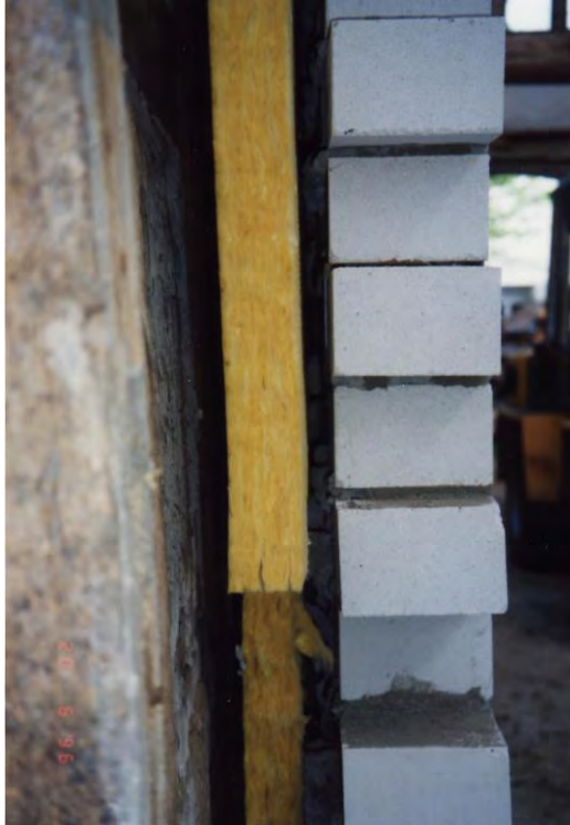
Bild 3: pendelnde Dämmung in der Luftschicht
