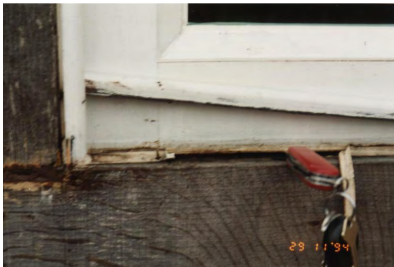
Bild 3.3-2 Fuge im Anschluß Fenster – Riegel bei Holzskelett-konstruktion [Foto: Schmidt]
