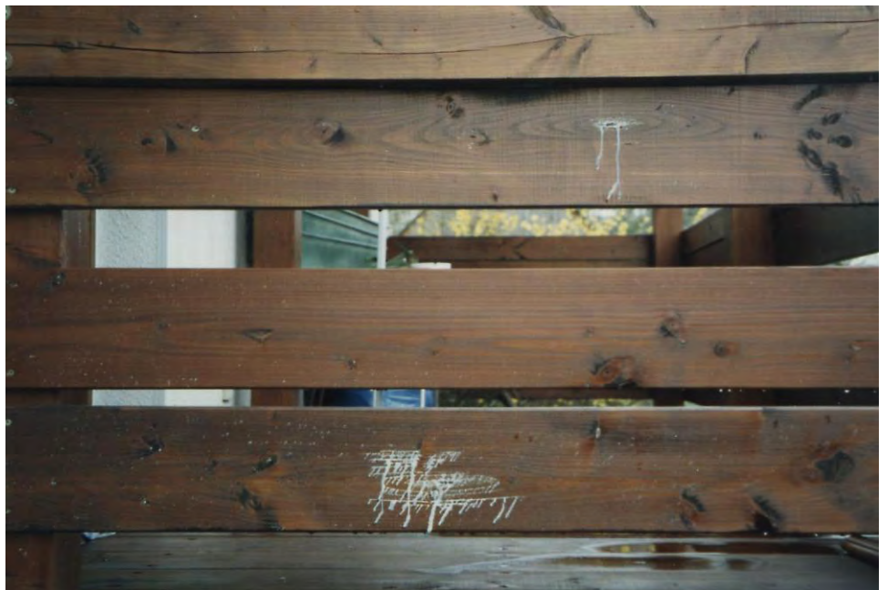
Bild 3.4-1 Nicht objektbezogene Holz- auswahl: Harzaustritt bei Balkongeländer [Foto: Steinmetz]
