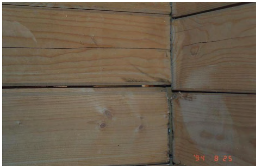
Bild 3.2-18 Fehlerhafte Ausführung: Blockbohlen ohne Verkämmung (durchscheinendes Licht) [Foto: Macha]
