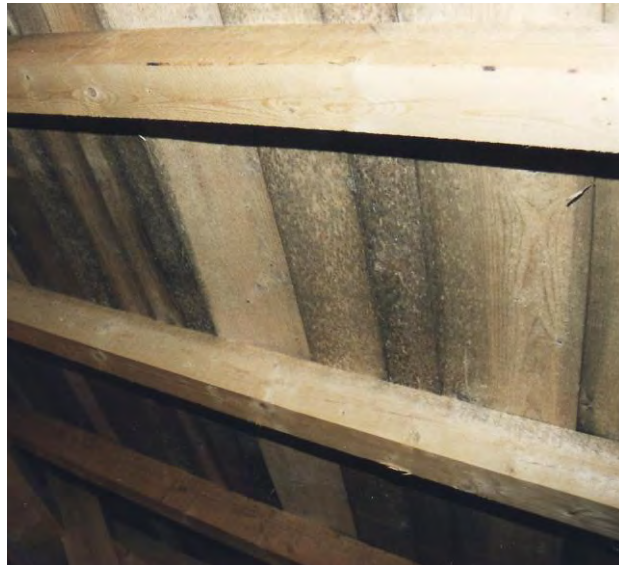
Oben: Bild 3: Starker Schimmelpilzbefall an der Unterseite der Dachschalung
