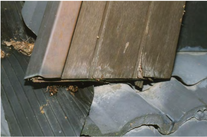
Bild 3: Abgelöstes Deckfunier an der Holzverkleidung der Dachgaube
