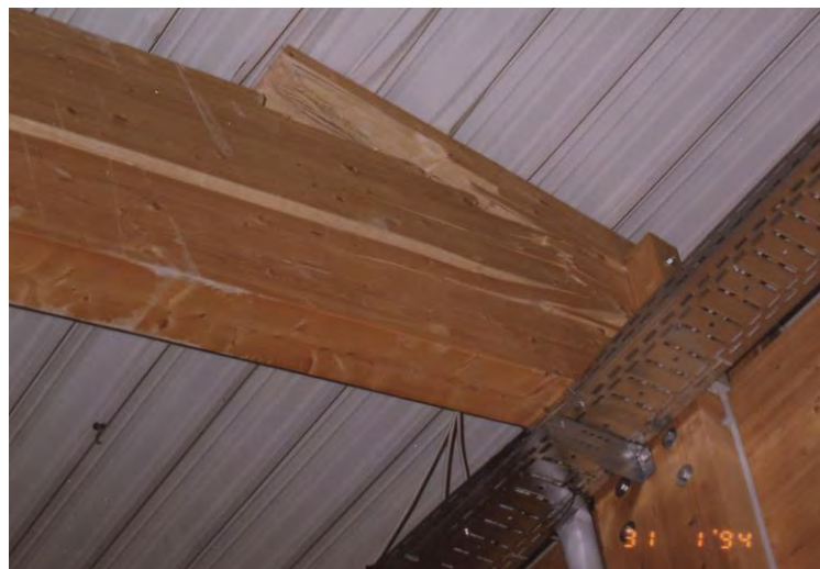
Bild 2: Zerstörter, aber nicht heruntergefallener BSH-Träger
