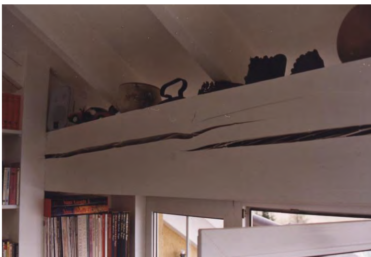
Bild 1 & 2: Ansicht des 25 mm breit aufklaffenden Trockenriß in der Mittelpfette.
