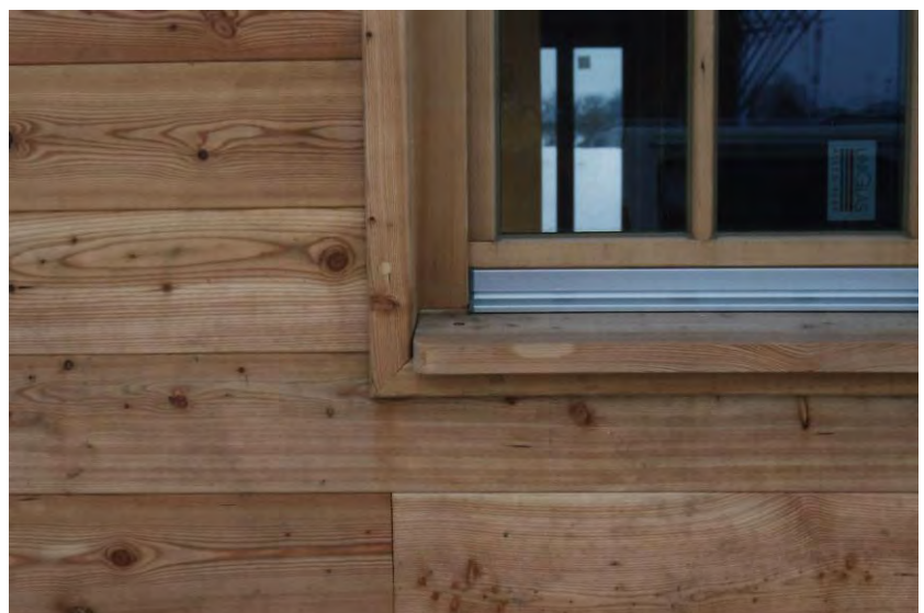
Bild 6.3-28 Fenster-Sohlbank ohne seitliche Aufkantung
