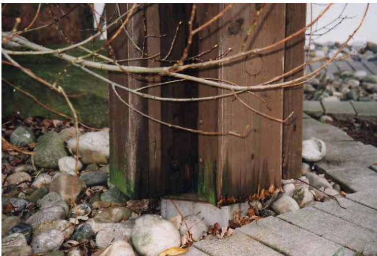
Bild 1: Stützenfuß mit Holzerstörung, zu nahe am Boden
