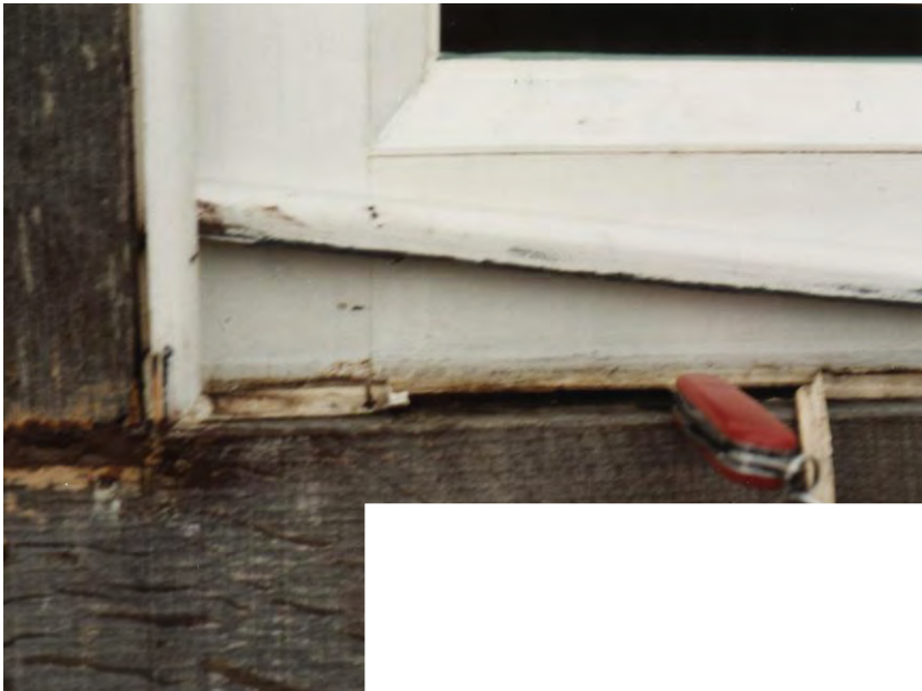
Bild 2: Ansicht der entfernten äußeren Verleistung und der darunterliegenden offenen Fuge
