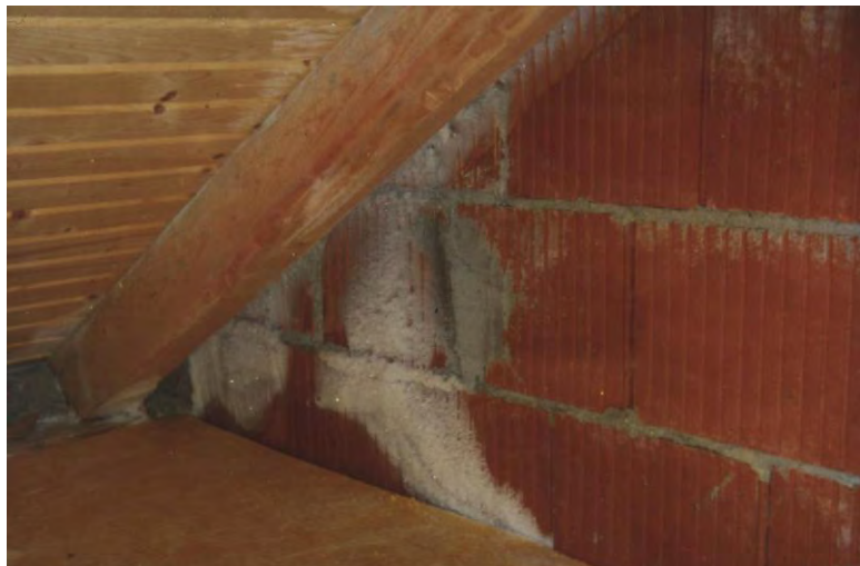
Bild 2: Starke Eisbildung an der Giebelwand im Spitzboden
