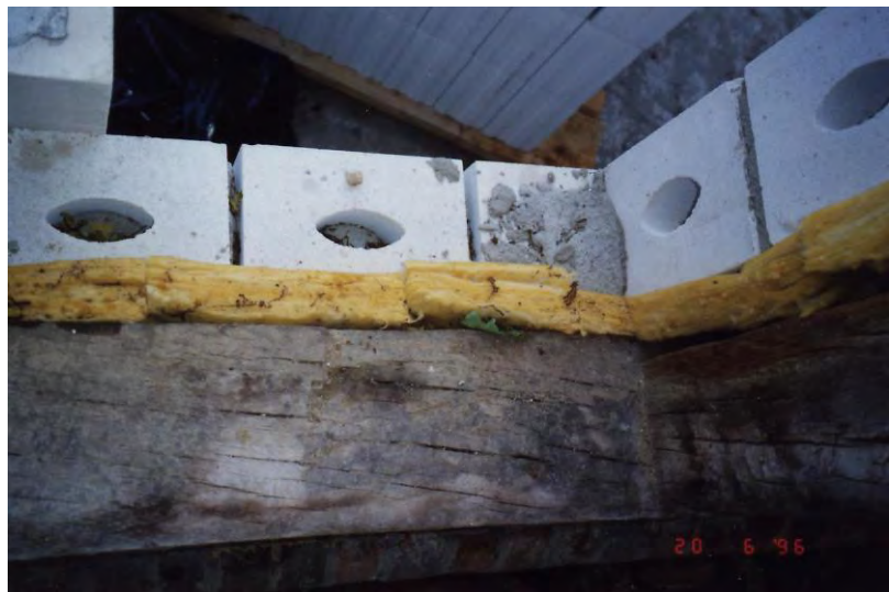
Bild 5.4-2 Nicht gewährleistete Hinterlüftung durch fehlenden Hohlraum [Foto: Schmidt]
