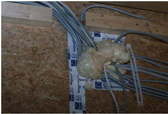
Bild 3.3-17 Ausgeschäumte Kabeldurchdringung: links:dicht, unmittelbar nach dem Ausschäumen rechts:undicht nach zurechtschneiden
