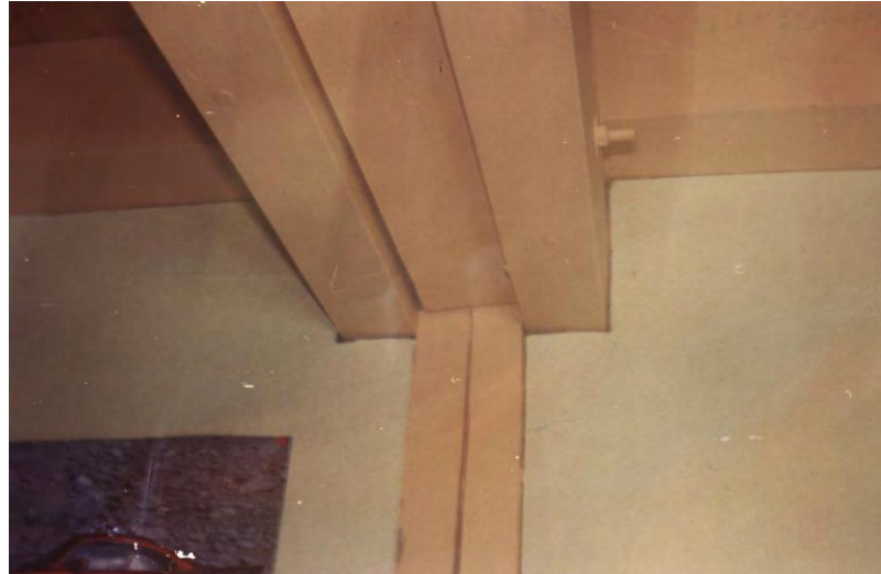
Bild 1: Stütze und Zange mit umlaufend offenen Anschlüssen
