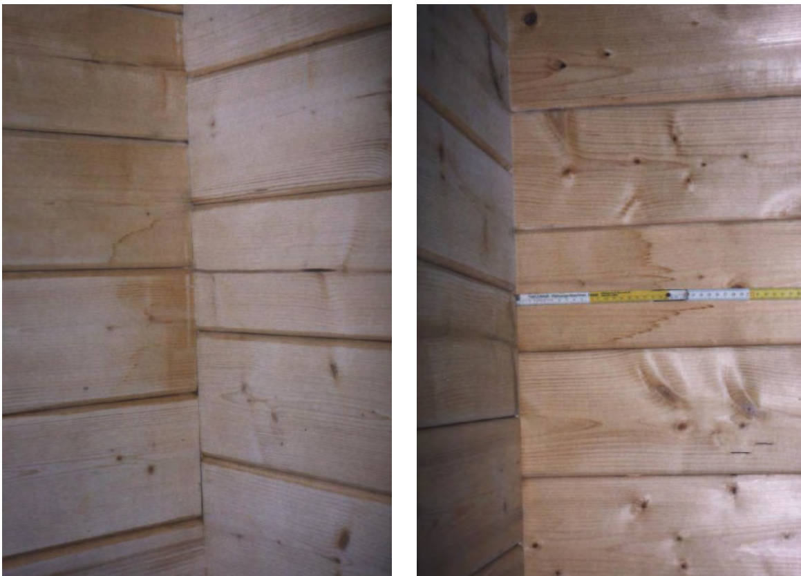
Bild 1 & 2: Ansichten der Eckverkämmungen und der sich abzeichnenden Wasserspuren
