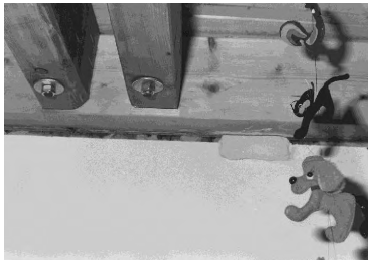
Bild 2: Fuge zwischen der Leichtwand im DG und der Dachgeschoßdecken-Konstruktion als Maß für die Absenkung der Erdgeschoßdecke gegenüber der unabhängig davon gelagerten Dachkonstruktion
