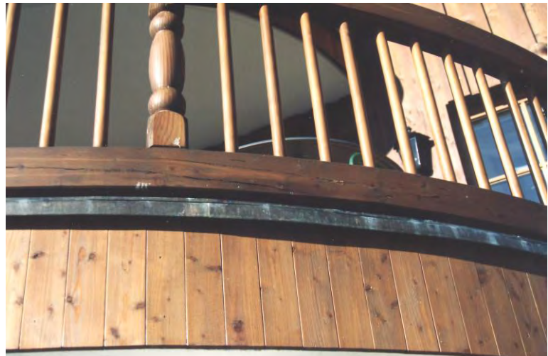
Bild 1: Ansicht des Balkons und der Risse in der Decklamelle
