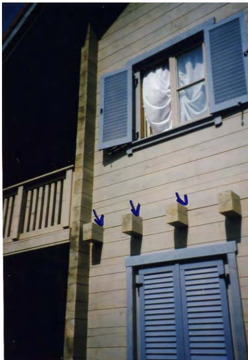
Bild 1: Südostseite des Hauses. Die Balken der Decke durchdringen die Außenwand. Dort kann Regenwasser eindringen.
