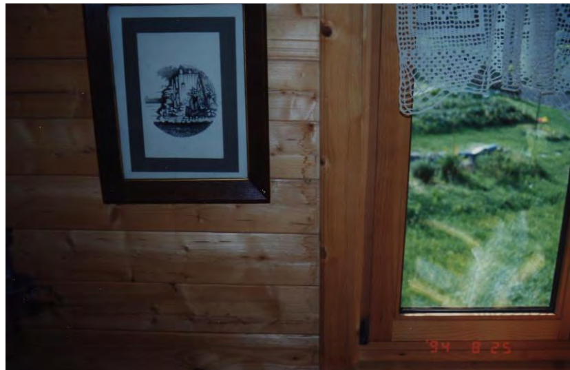
Bild 5.4-3 Wassereintritt (sichtbare Wasserflecken) durch undichten Fensteranschluß [Foto: Macha]
