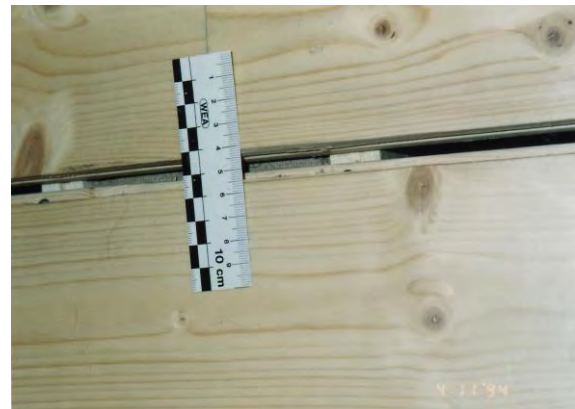
Bild 2: Geöffnete Fuge über Deckenbalken und darauf angebrachten Glattkantbrettern
