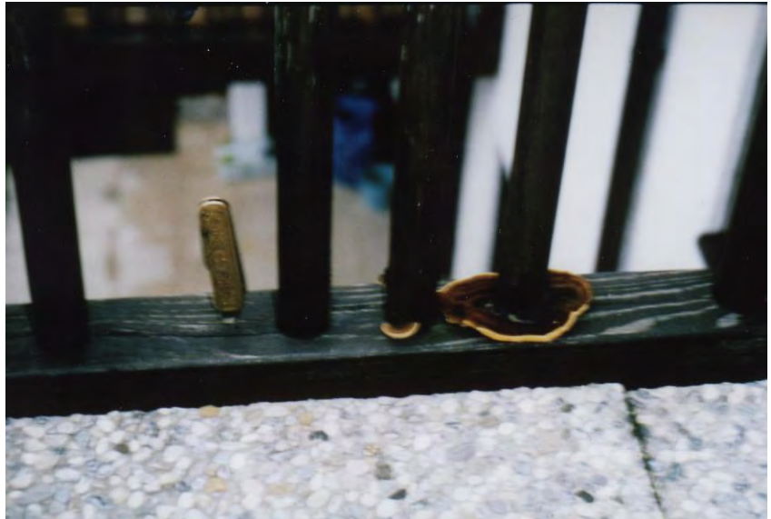
Bild 6.3-31 Pilzbefall im Bereich der Sprosseneinbindung [Foto: Trübswetter]
