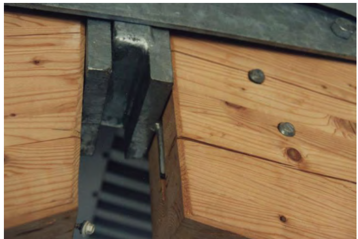
Bild 4.4-12 Querkzugrisse bei großflächigen Anschlüssen mit Stahlteilen [Foto: Steinmetz]
