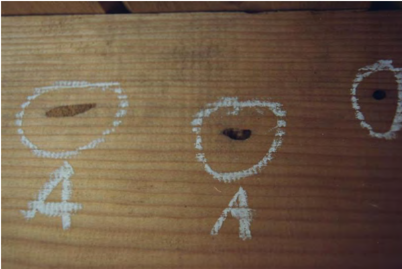
Bild 2: Fraßgänge, ein Ausflugloch ist mit Bohrmehl verstopft
