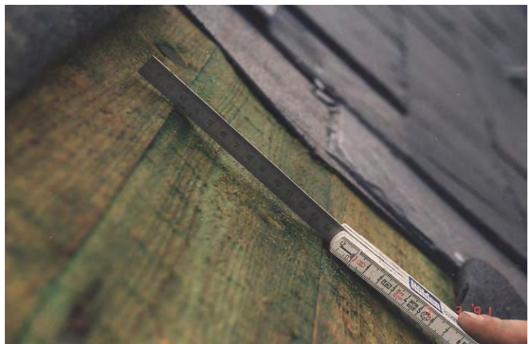
Bild 2: Die durch Dampfkongvektion befeuchtete Schalung ist aufgequollen
