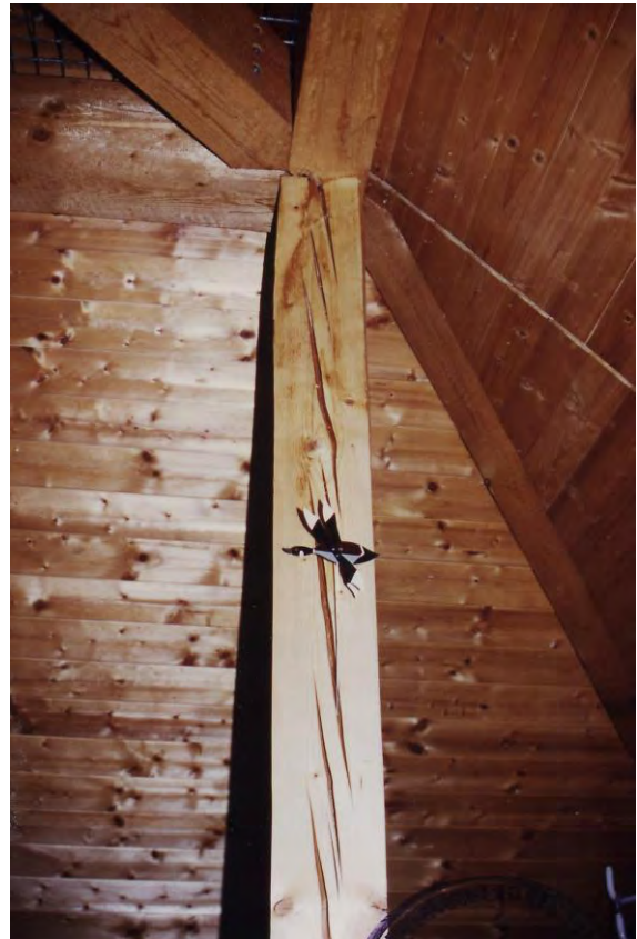
Bild 2: Trocknungsrisse in Stütze ② im Obergeschoß
