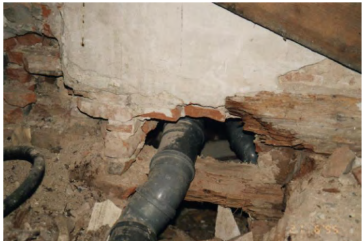
Bild 1 (oben) und 2 (unten): Verfaulte Balken mit Abflußrohr
