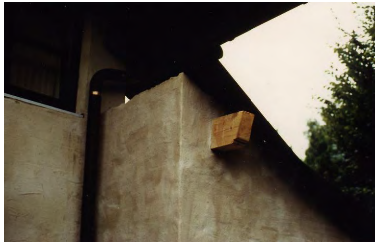
Bild 2: Auskragende Fußpfette, ohne Funktion
