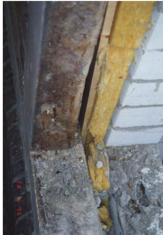
Bild 1: die Luftschicht ist teilweise mit Mörtelresten verfüllt
