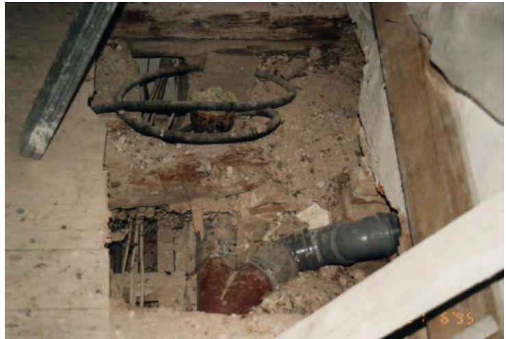
Bild 1 (oben) und 2 (unten): Verfaulte Balken mit Abflußrohr
