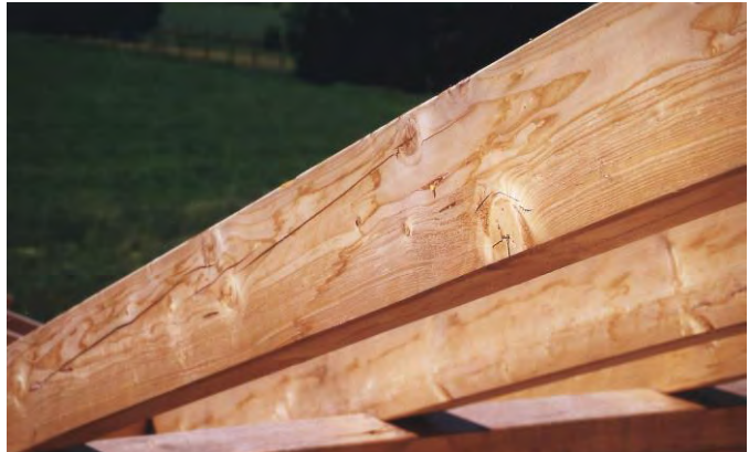
Bild 3: Risse und Wasserflecken an den Sparren
