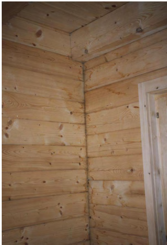
Bild 1: Wasserflecke im Bereich der Verkämmung der Außenwand
