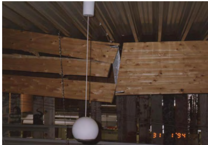
Bild 3: Zerstörtes Gerbergelenkauflager
